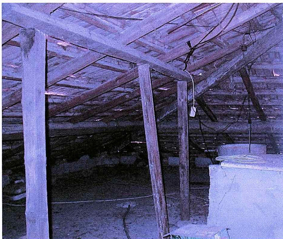
Struttura di copertura attuale
