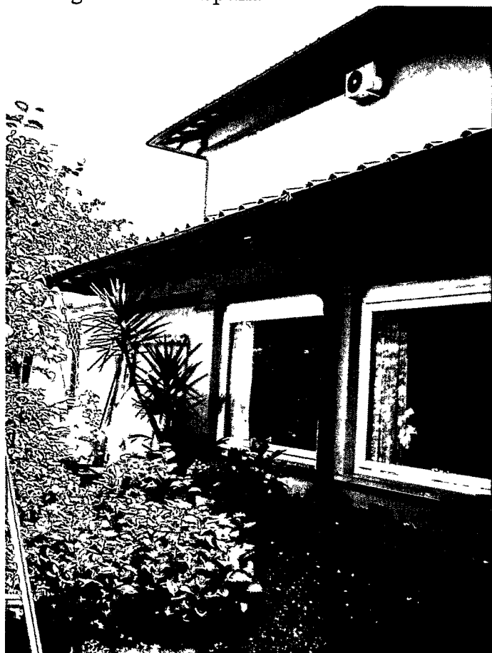
Foto n° 12: Vista lato La Spezia verso monti
