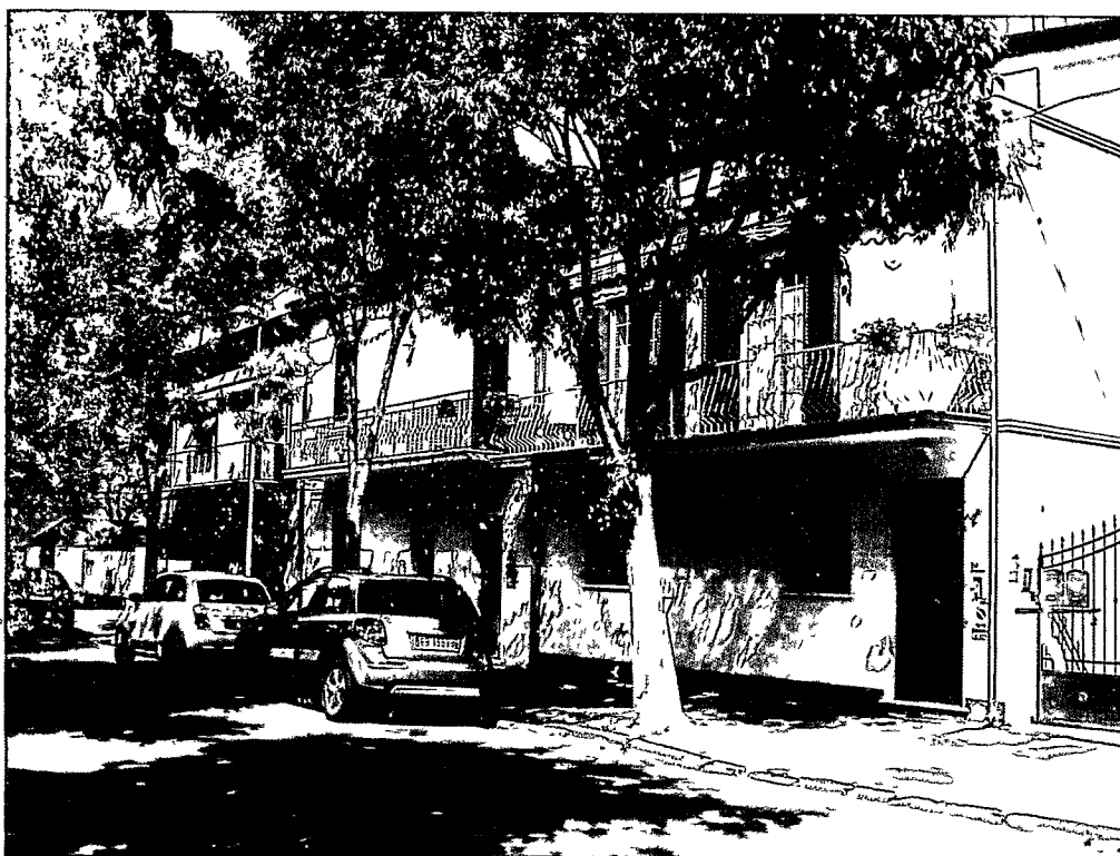
Foto n° 2: Via Cadorna edifici prospicienti
