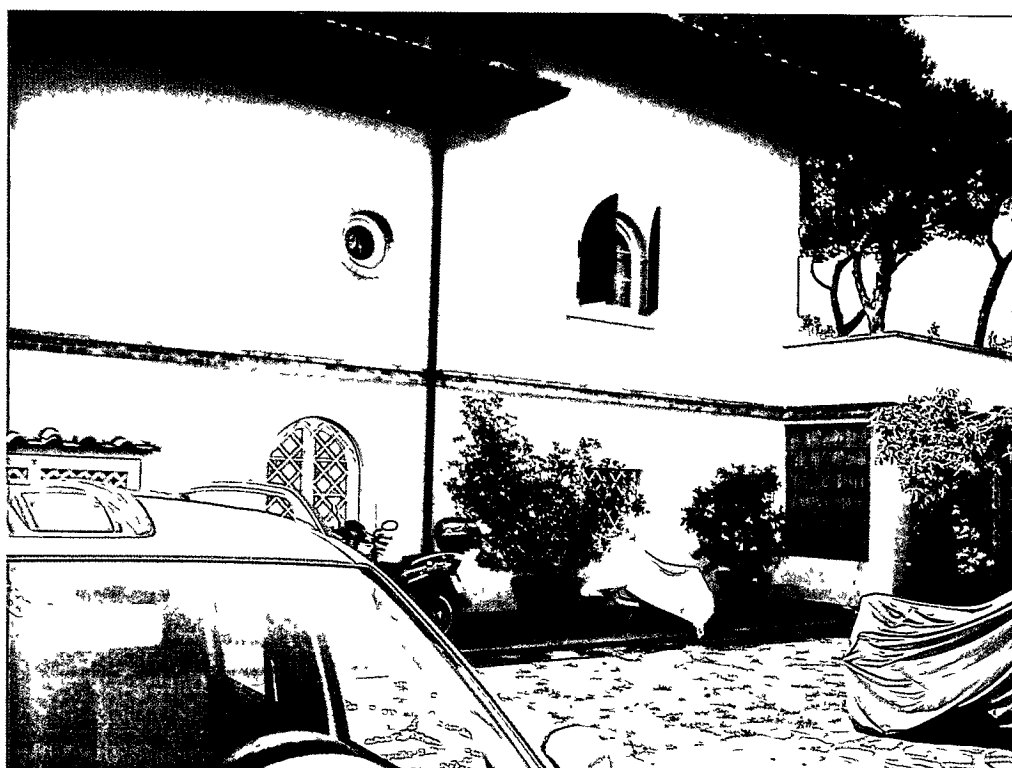
Foto n° 20: Vista lato monti verso La Spezia
