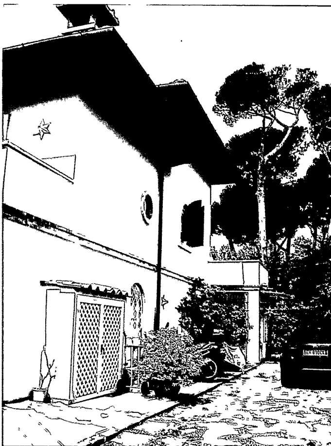
Foto n° 18: Vista lato monti verso La Spezia
