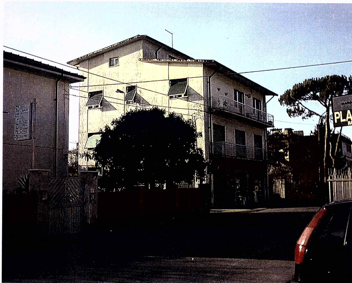
VIA PROV. - FACCIATA EST e NORD.
