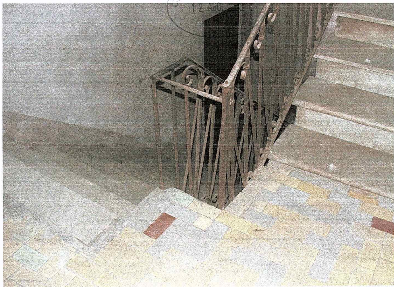
INTERNO : SCAIA D'ACCESSO AL PRIMO PIANO - CONDOMINIALE
