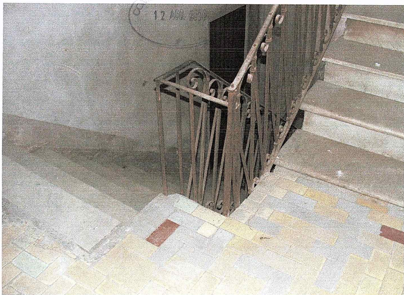
INTERNO : SCALA DI ACCESSO AL PRIMO PIANO - CONDOMINIALE -
