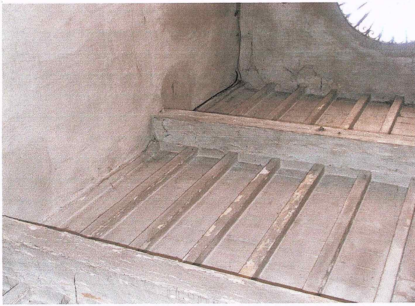
SOFFITTO ATRIO D'INGRESSO CONDOMINIALE
