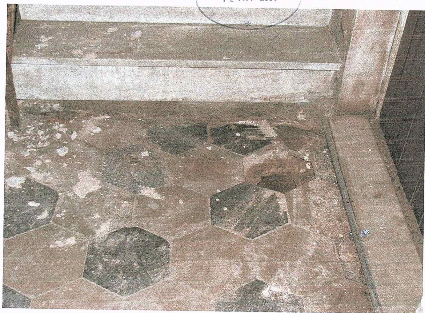
INTERNO: PAVIMENTAZIONE ATRIO D'INGRESSO - CONDOMINIALE -
