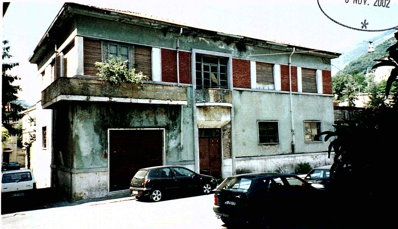
Vista da via dell'amico - fabbricato esistente mantenuto in parte nell'intervento progettuale
