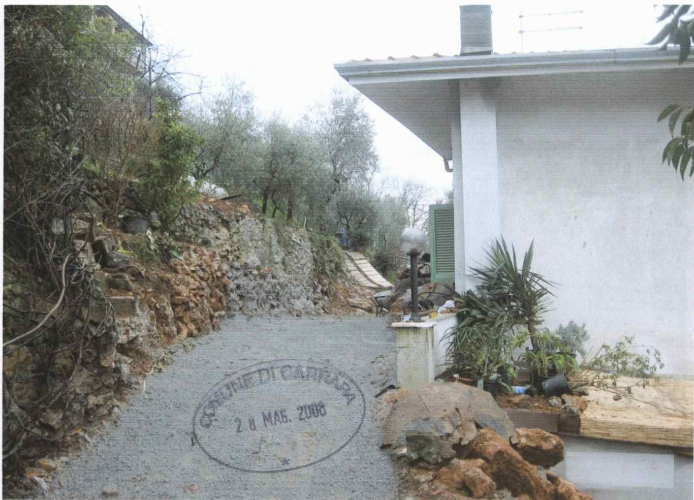
2) VISTA AREA RETROSTANTE "DI SEDIME"
