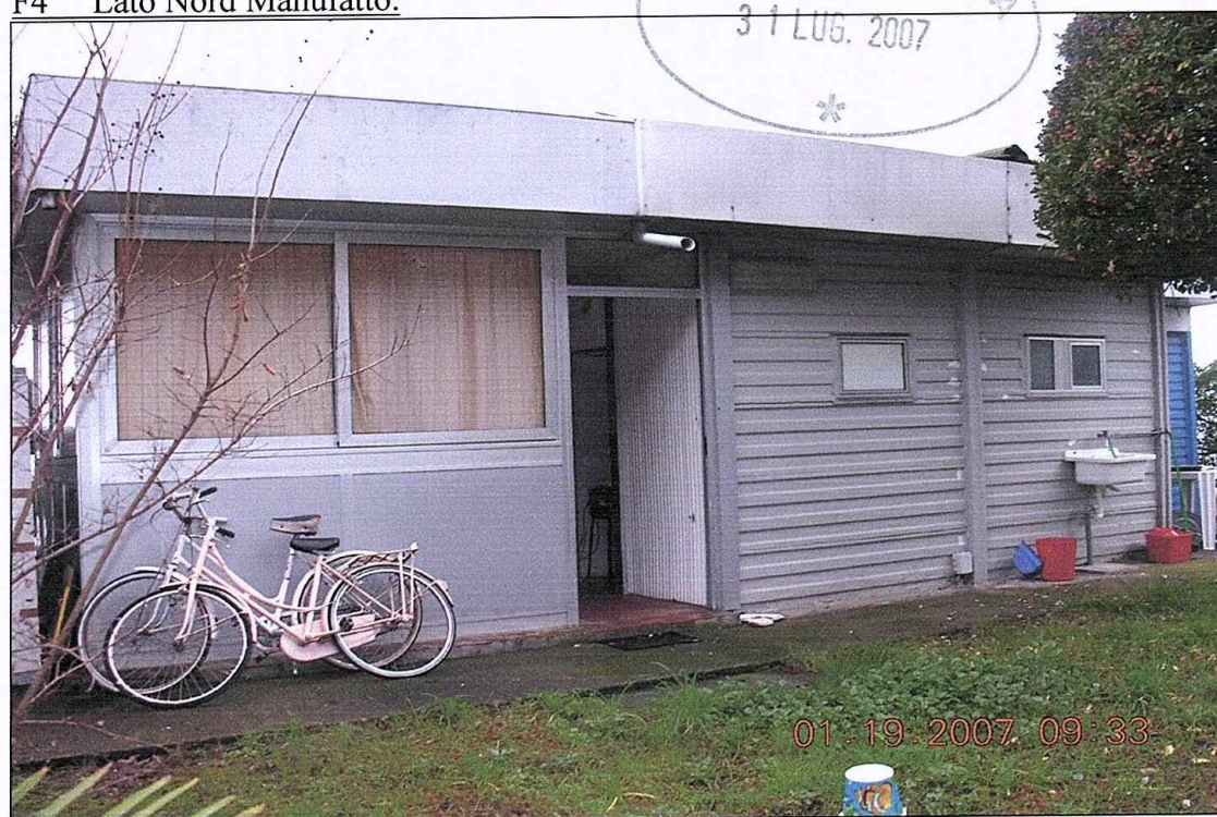
F4 Lato Nord Manufatto.
