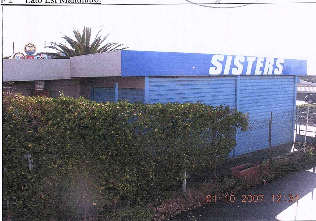
F 2 Lato Est Manufatto.
