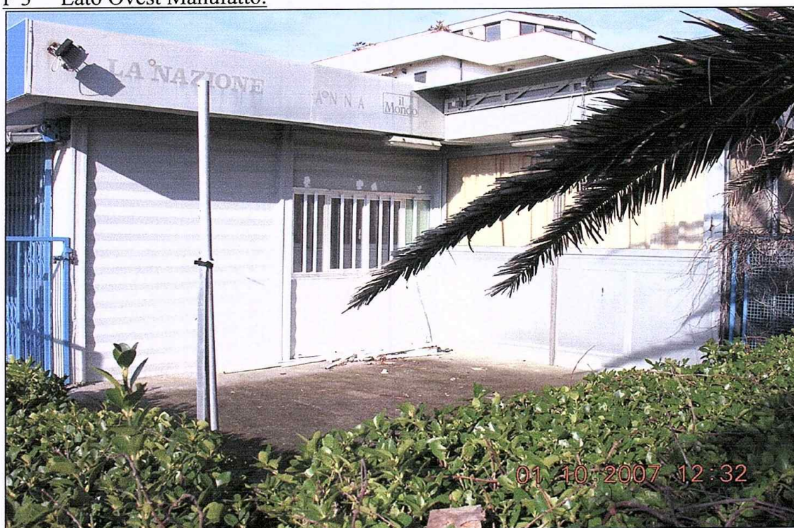
F3 Lato Ovest Manufatto.
