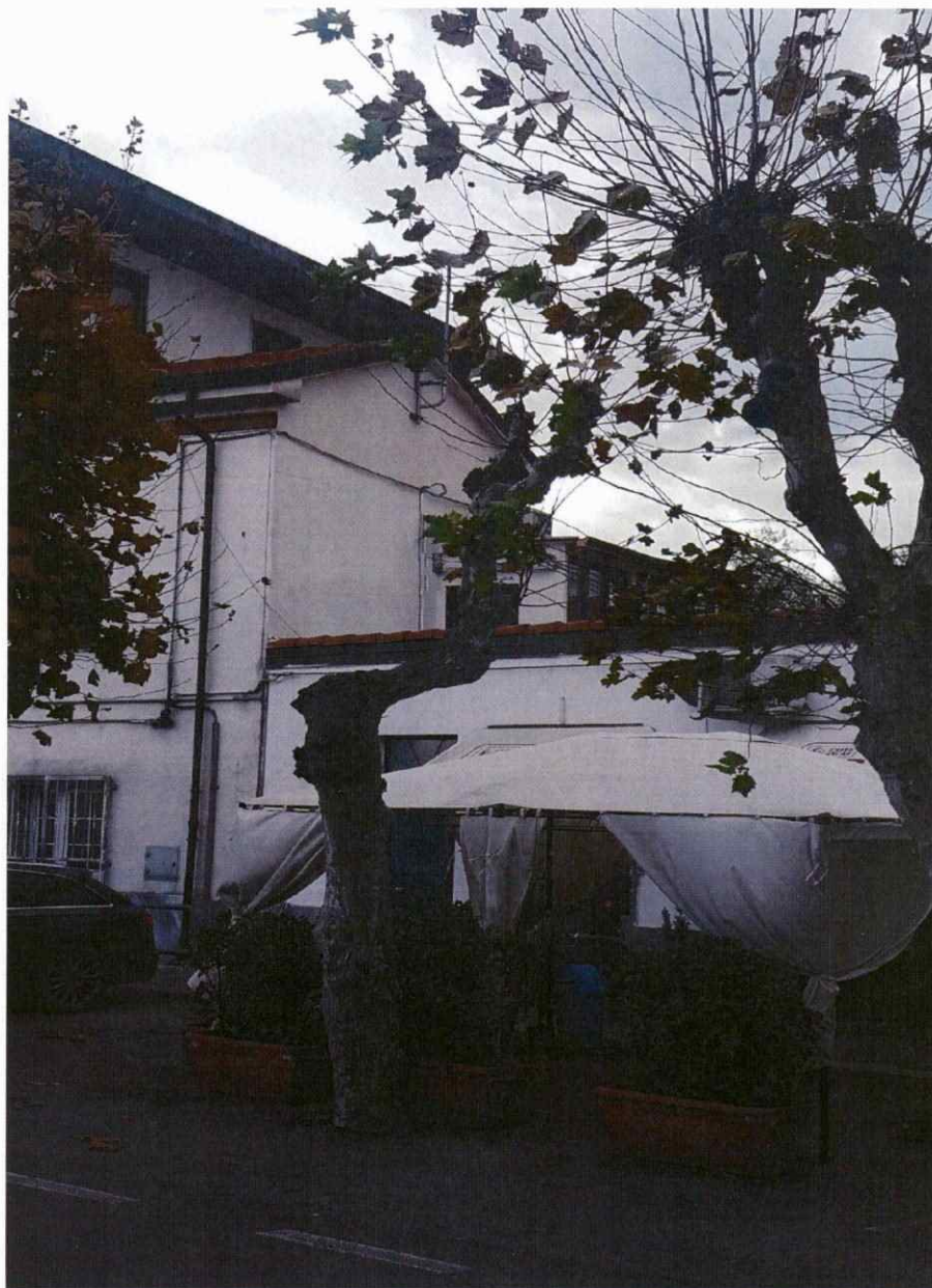
Vista da fronte strada attuale
