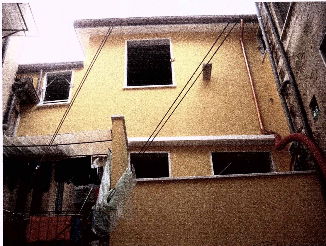
STATO PROGETTO VISTA INTERNA – Foto 4
