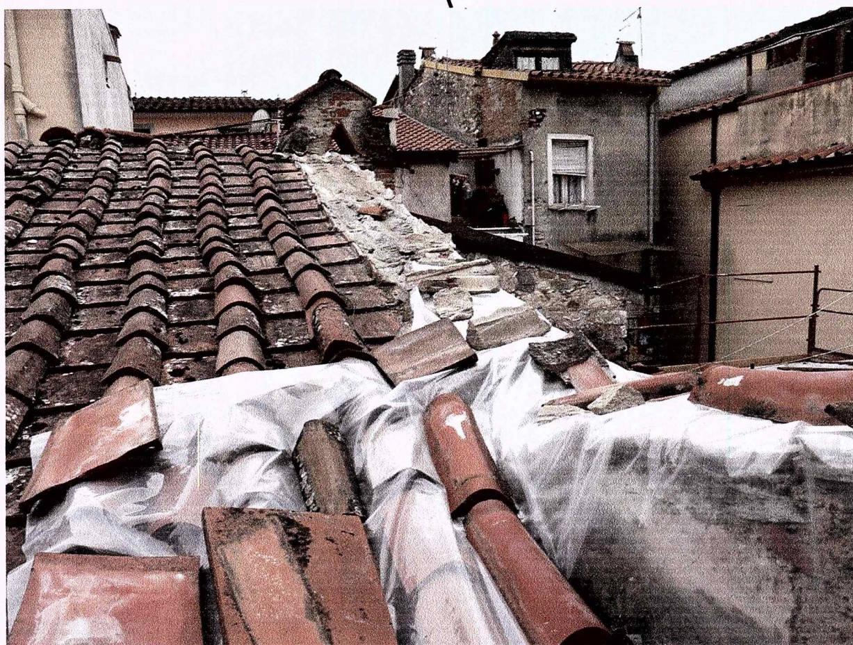
COPERTURA ESISTENTE – foto 5
