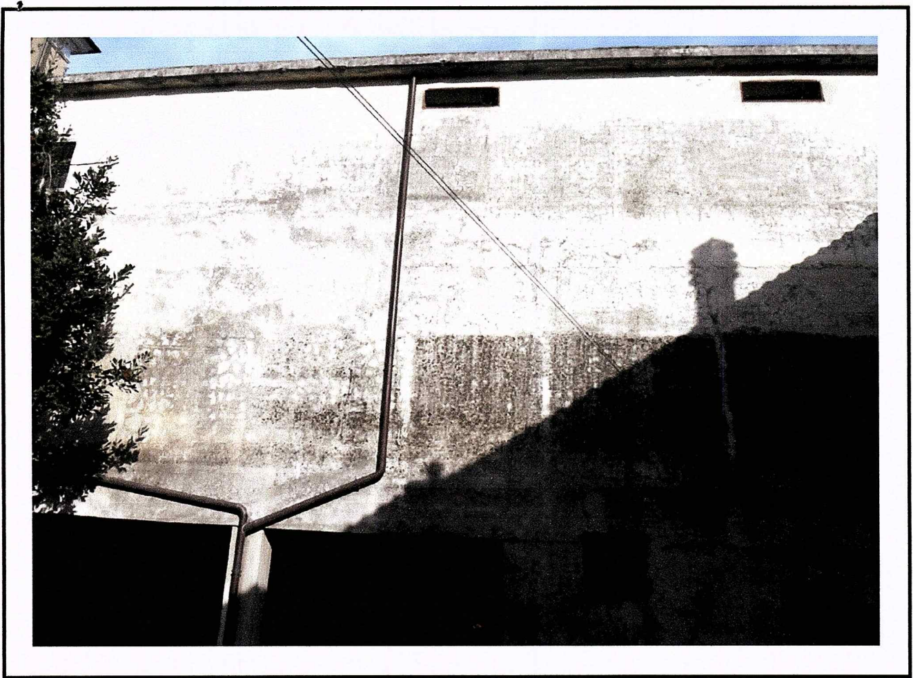
FOTO N.4 FRONTE LATO CORTILE - PROSPETTO SUD
