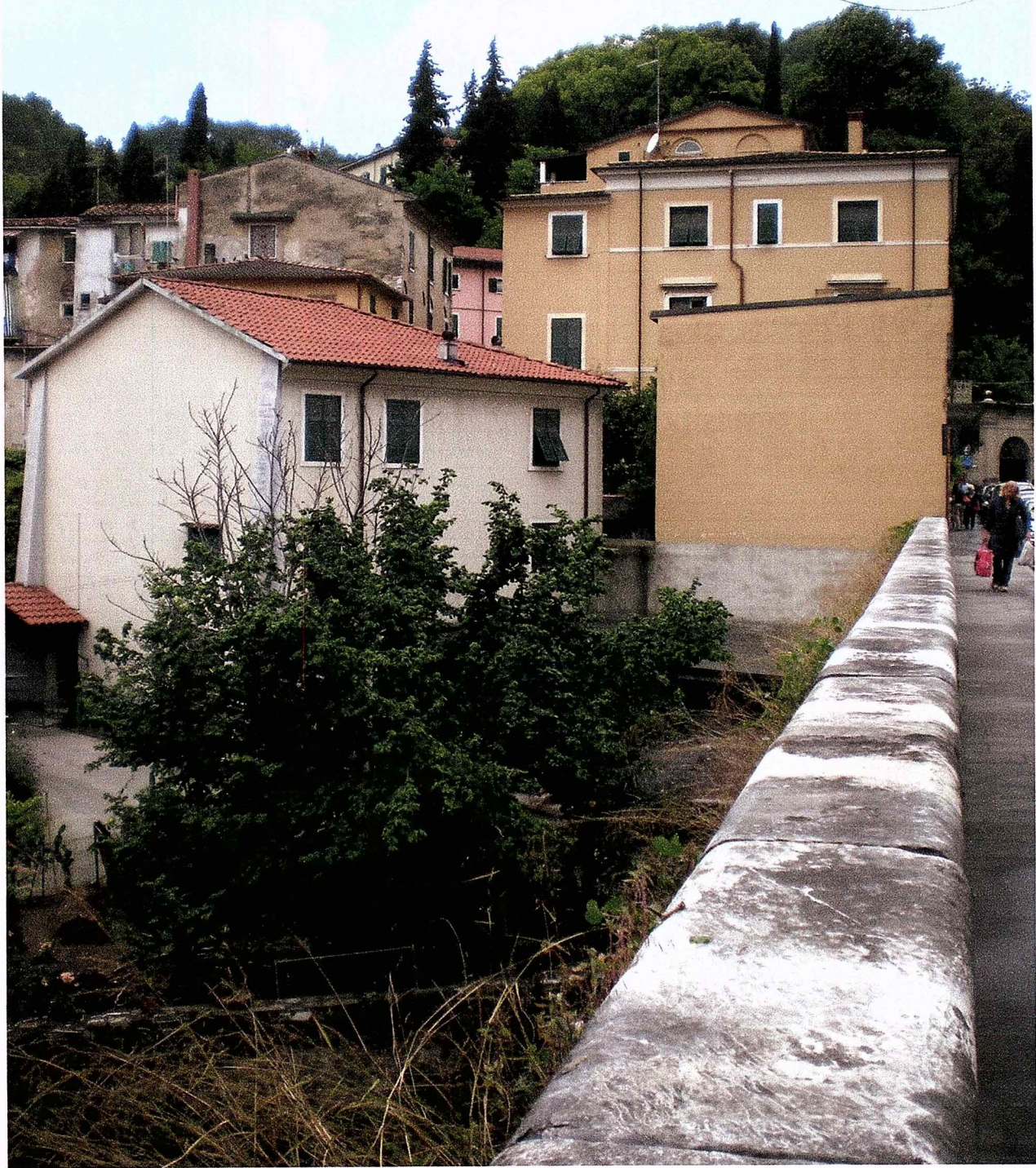
FOTO N. 1 FIANCO EDIFICIO - PROSPETTO EST -
