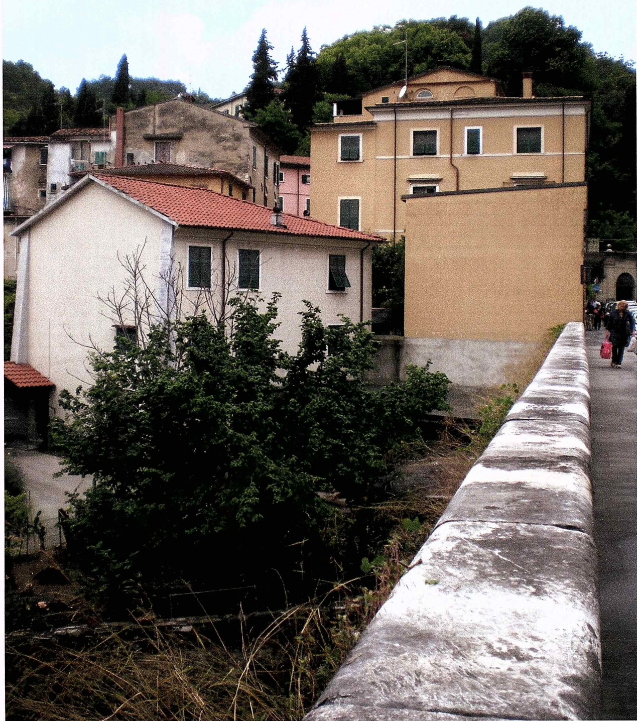
FOTO N. 1 FIANCO EDIFICIO - PROSPETTO EST -
