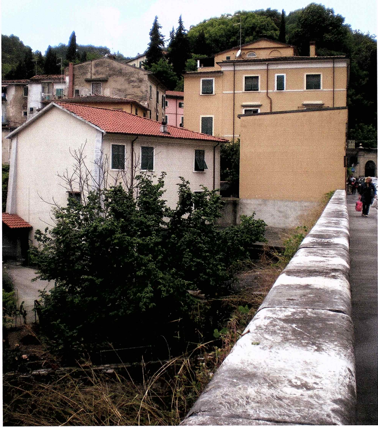
FOTO N. 1 FIANCO EDIFICIO - PROSPETTO EST -
