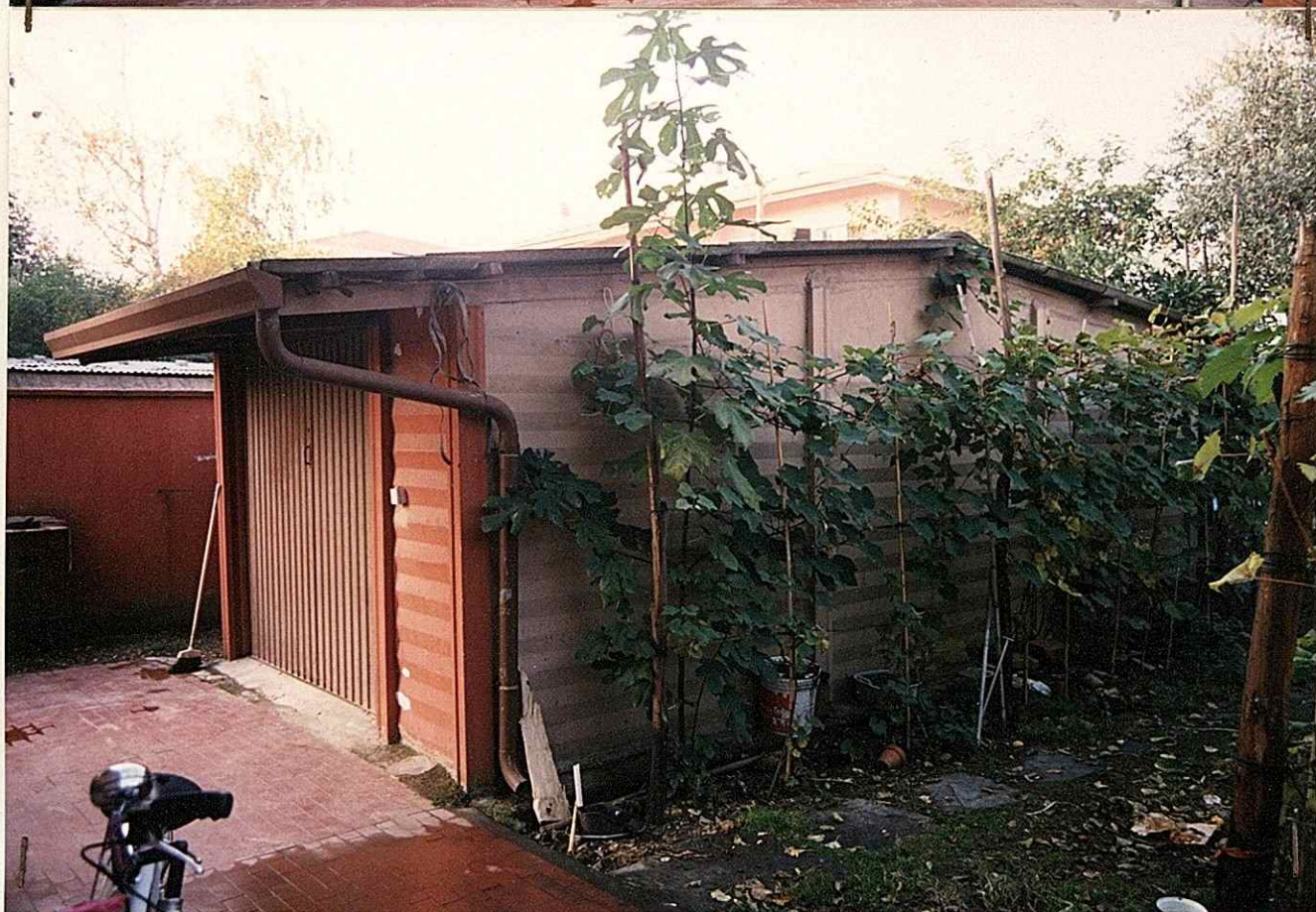
Prefabbricato adibito a garage - ubicato a Marina di Carrara - via vicinale Macchia n. 5I - Proprietà sig.ra SOLDATI ROSALINDA. Pratica di condono edilizio n. 480 del 2I/OI/I986.
