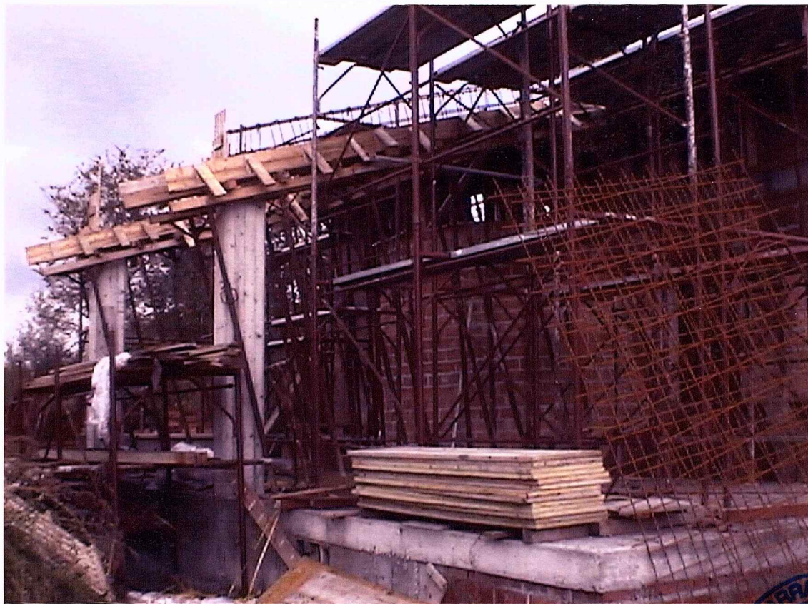
FOTO 3. Prospetto lato mare
