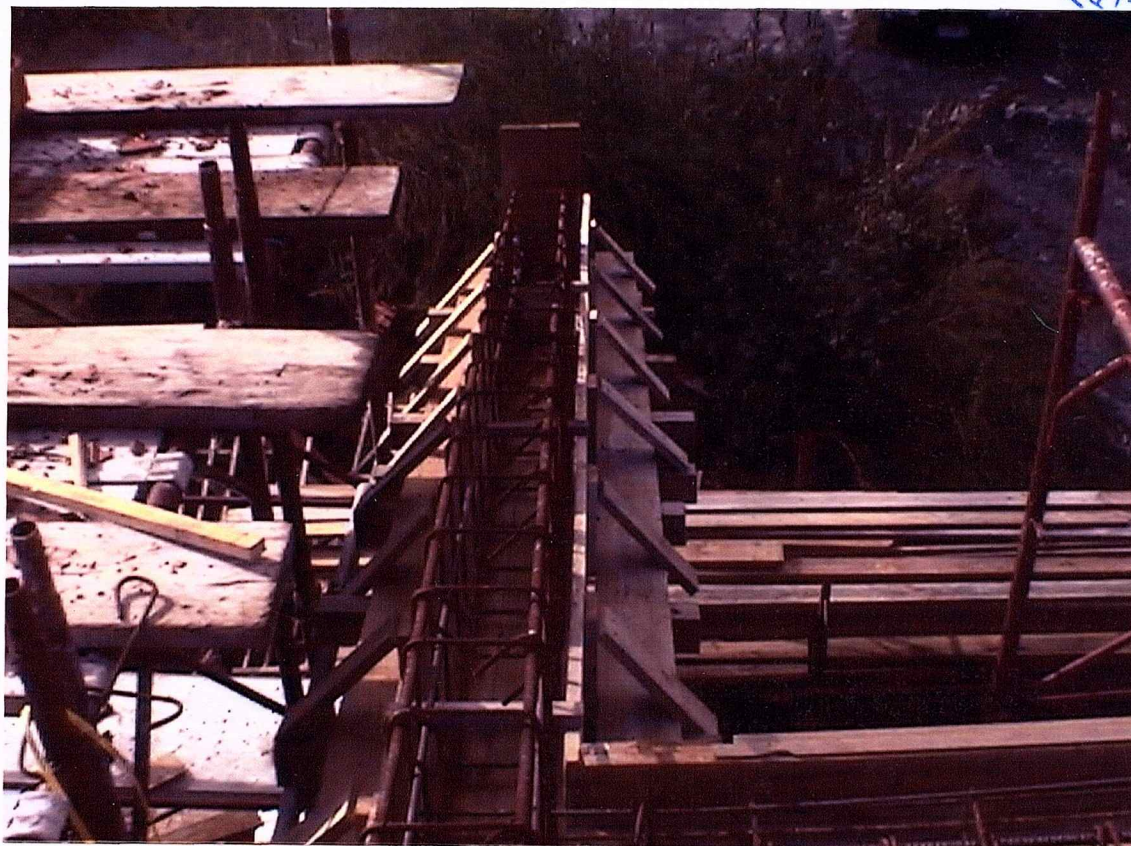
FOTO 4. Particolare della trave a vista della copertura nell'aggancio al pilastro
