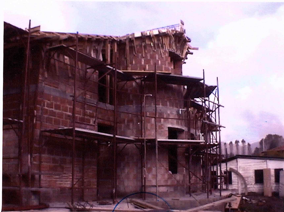
FOTO 1. Prospetto lato Massa.
