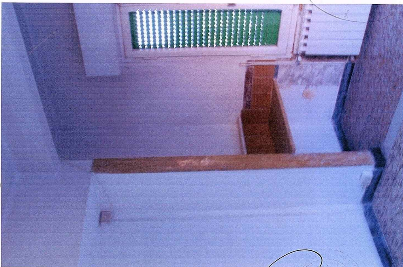
foto n° 6 - particolare degli interni - piano primo
