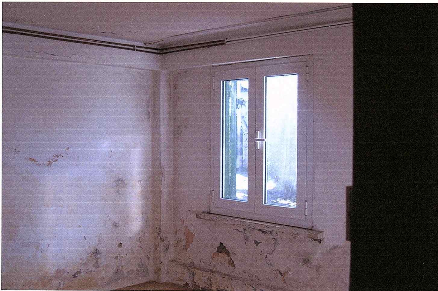
foto n° 7 - particolare degli interni - piano terra
