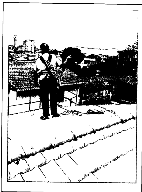
Ora potete lavorare su questo settore del tetto e della falda.
