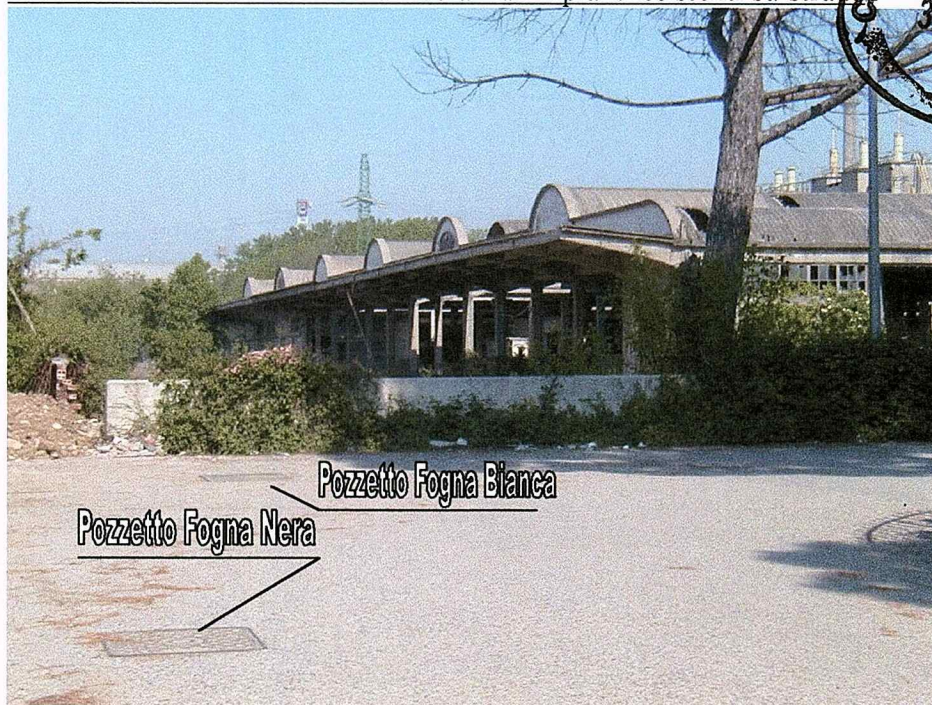
Foto-3 Viabilità esistente e Particolari di impianti esistenti su strada
