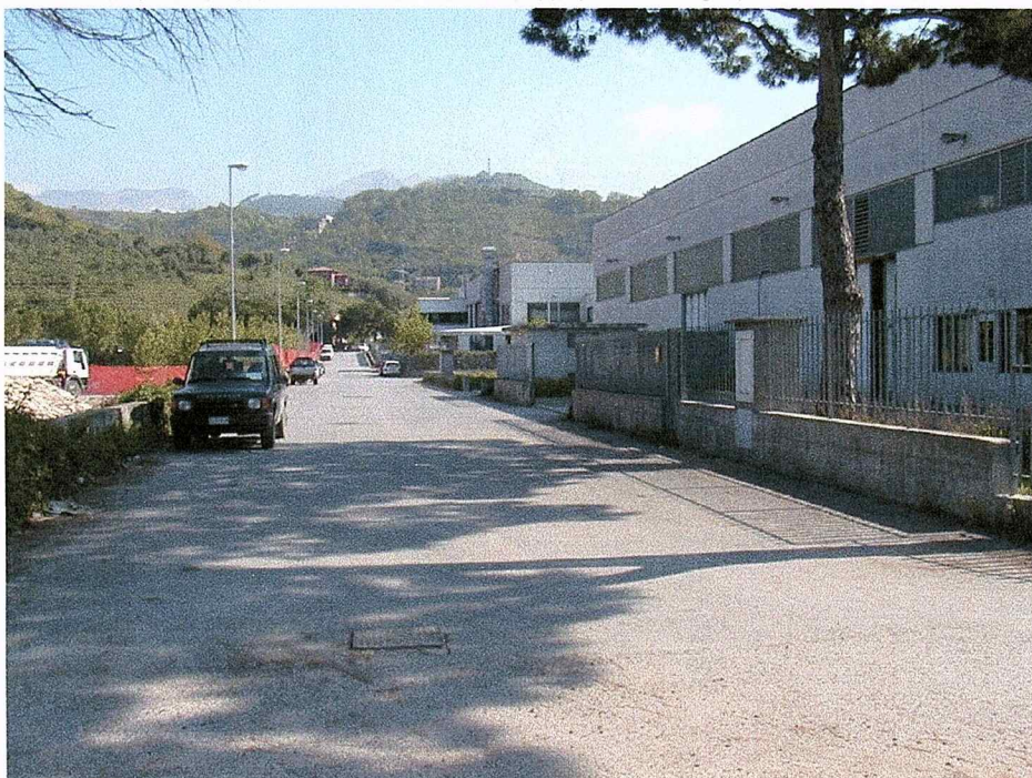
Foto-2 Viabilità esistente a confine con Area ex FIBRONIT lato Massa Punto di scatto Confine SUD-EST area ex FIBRONIT
