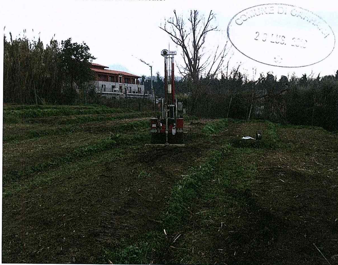
Foto n.2 Prova penetrometrica dinamica superpesante DIN2, eseguita lungo il pendio dove sarà costruito il nuovo fabbricato.
