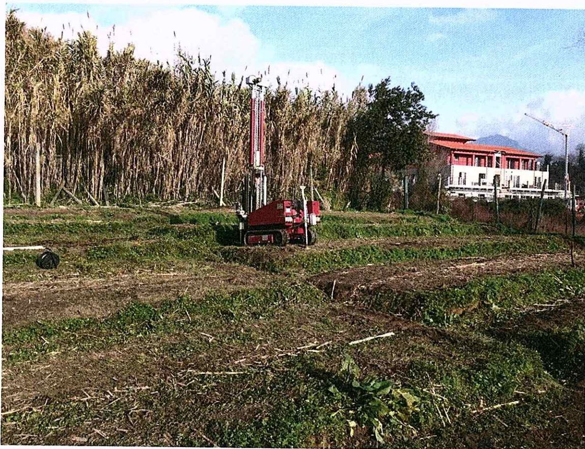
Foto n.1 Prova penetrometrica dinamica superpesante DIN1, eseguita lungo il pendio dove sarà costruito il nuovo fabbricato.
