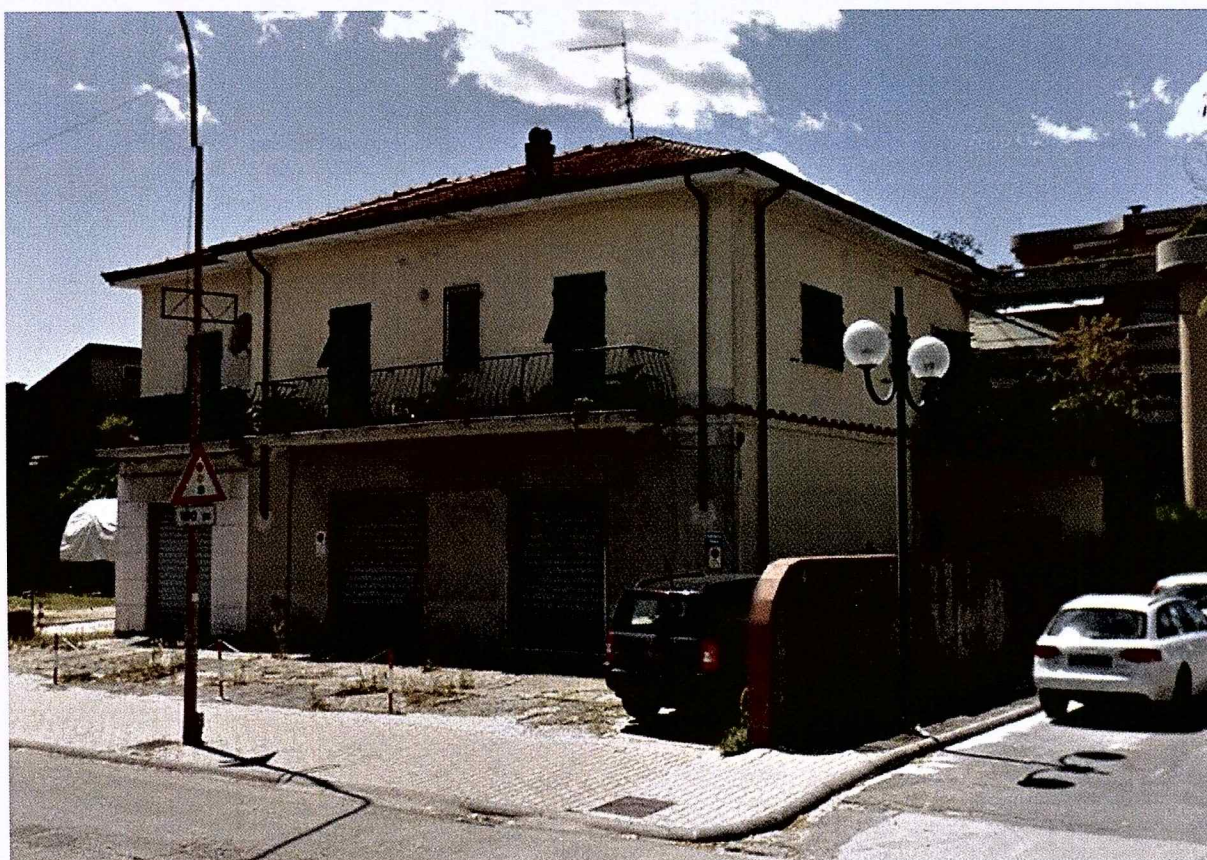
1 Vista generale da Viale Galilei: le tre aperture fronte strada e lo spazio antistante
