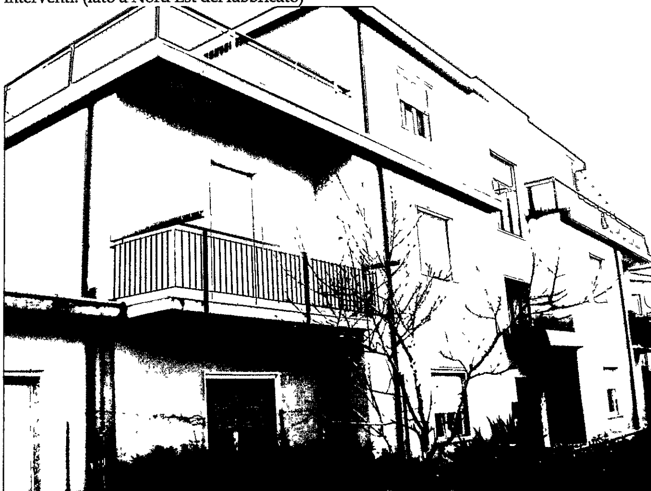
Foto1: vista della palazzina, in particolare del piano secondo, dove verranno effettuati gli interventi. (lato a Nord Est del fabbricato)
