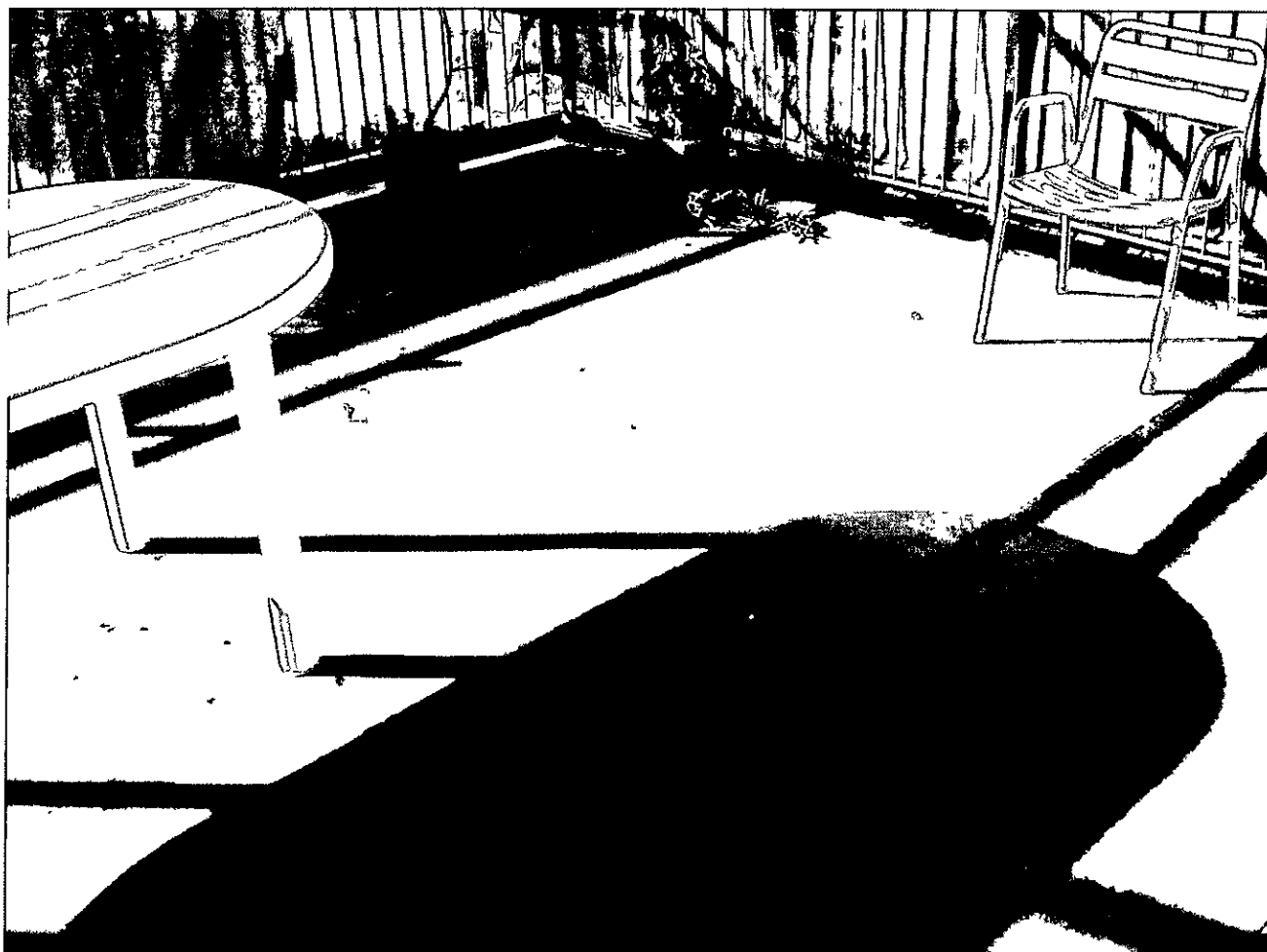
Foto4: vista della terrazza lato mare (Sud-Est)
