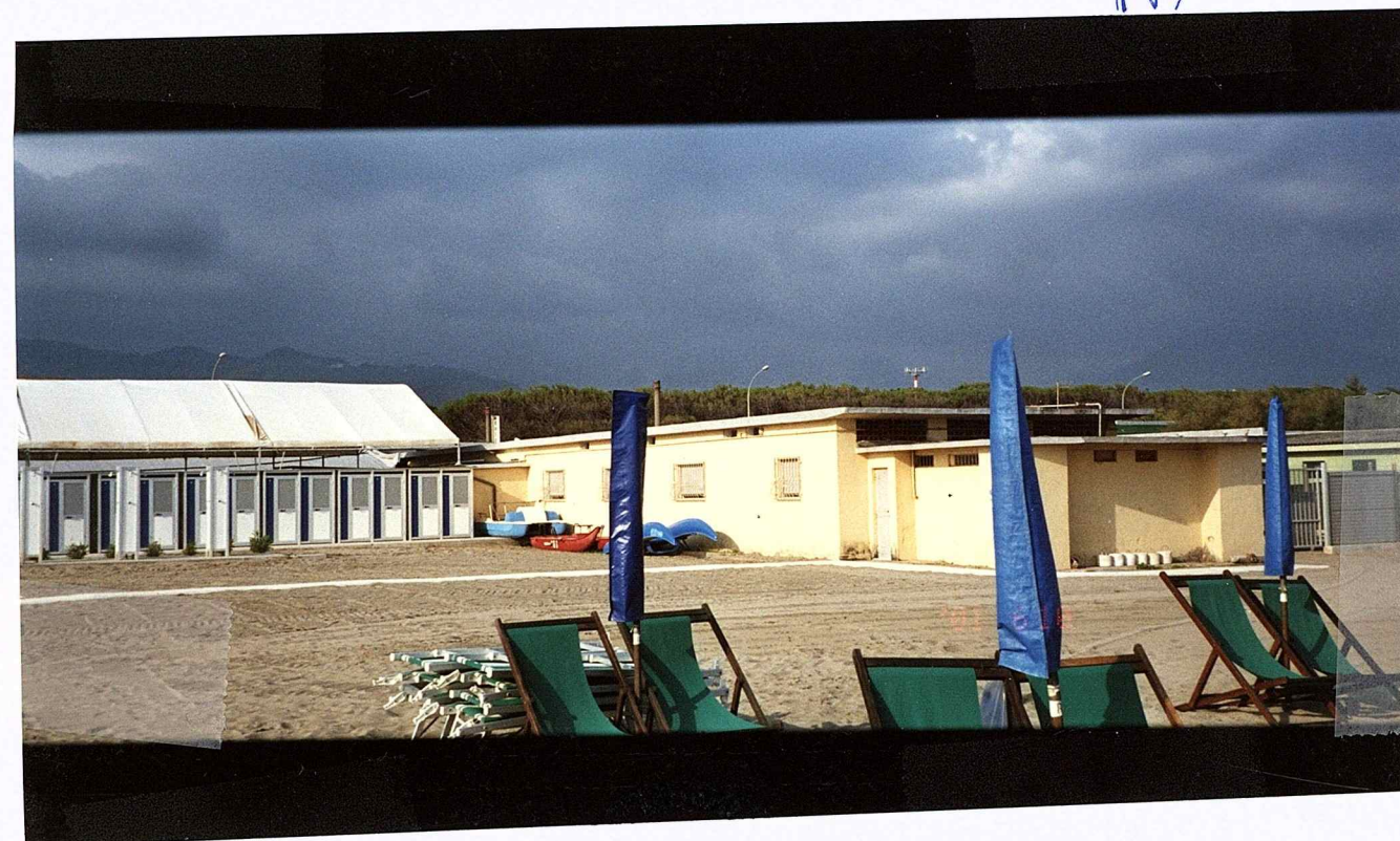
Sopra : Vista 5 – 5 : i Corpi A-1 e A-2 dalla spiaggia Sotto : Vista 5 – 5 : il Corpo A-6 dalla spiaggia
