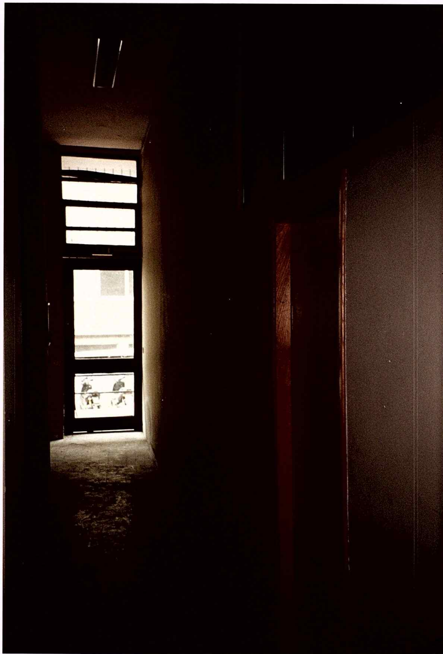
Rimozione pareti corridoio interno
