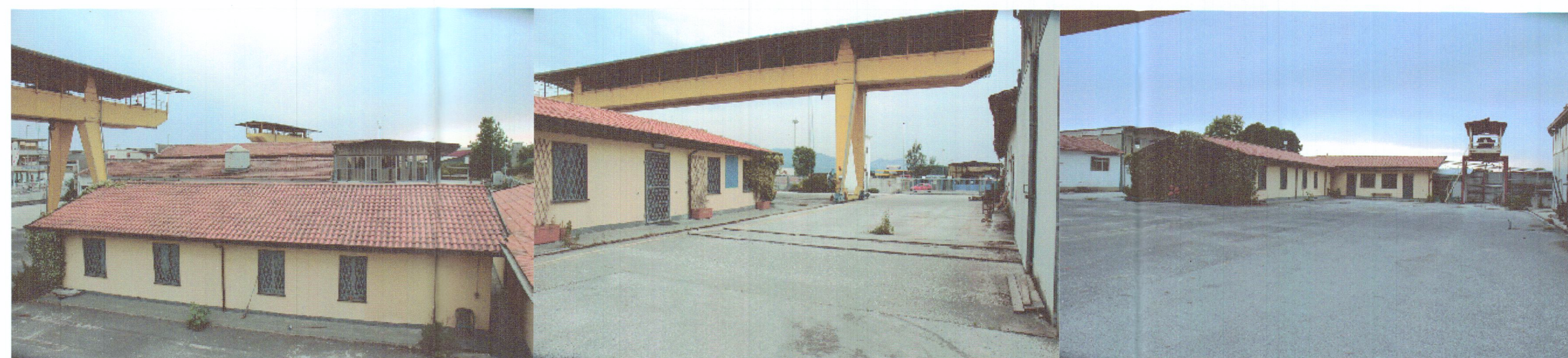
prospetto lato nord (foto n°1)
