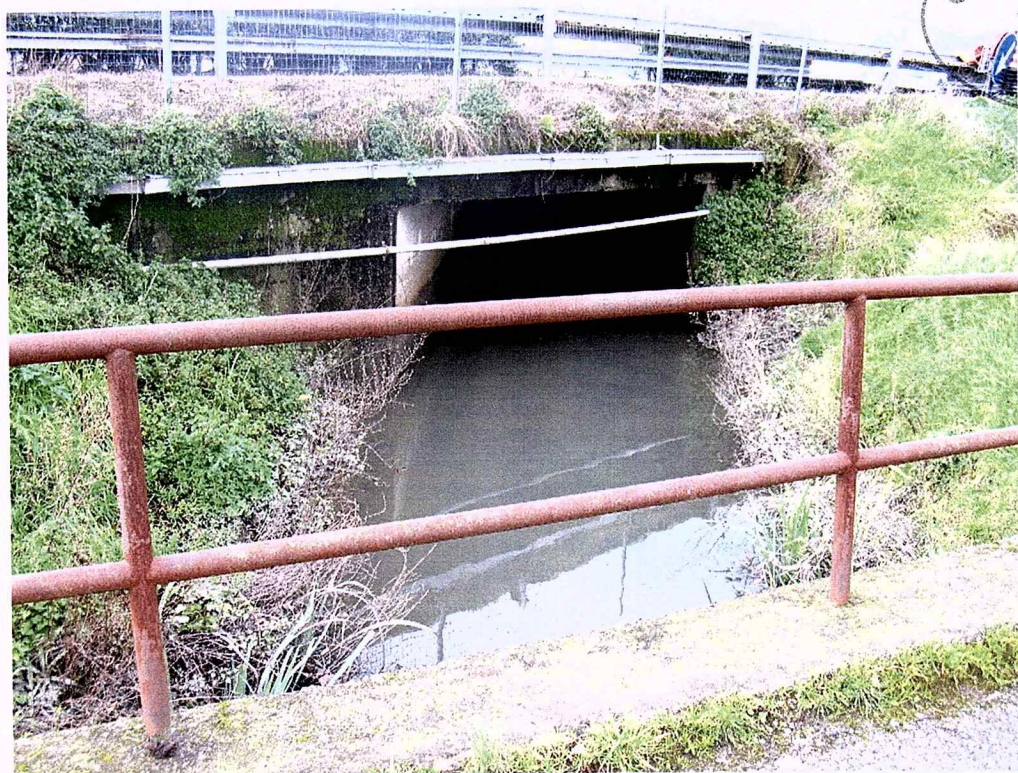
Foto 3-passaggio Fosso dei Due Canali sotto autostrada, vedi sezione 3 Tav.2
