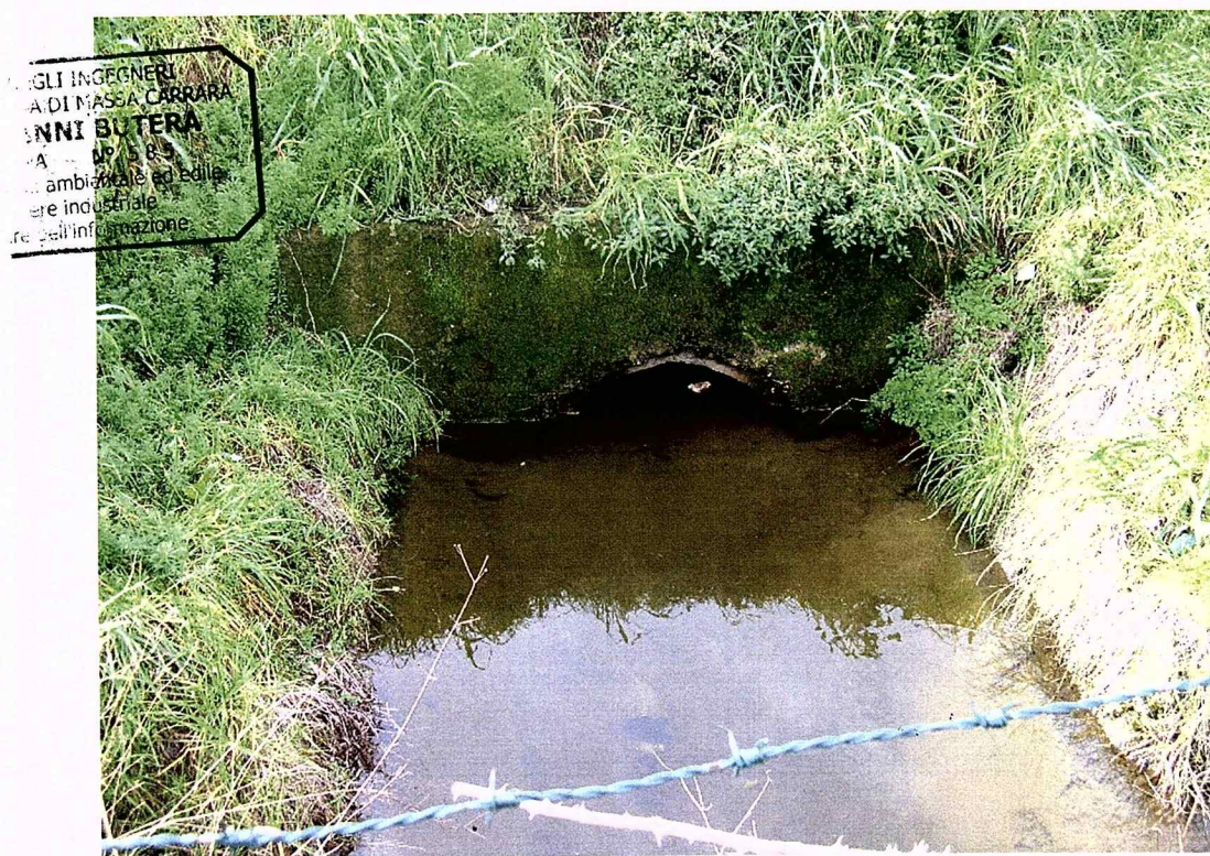
Foto 2-passaggio tubazione di scolo sotto autostrada, vedi sezioni 1 e 2 Tav.2
