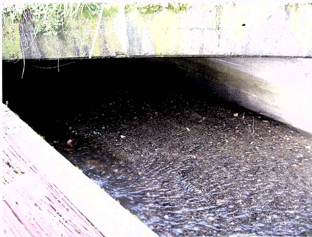
Foto 8-Passaggio Fossa Maestra sotto autostrada, vedi sezione 5 Tav.2
