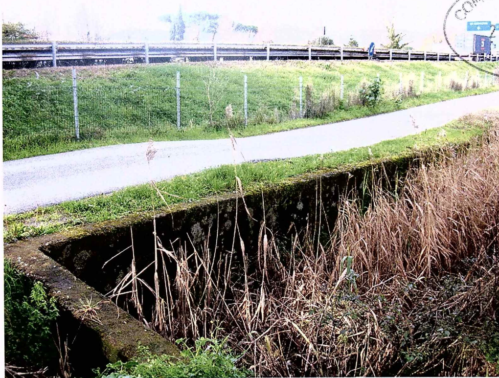
Foto 1- canale lungo via Pontremoli
