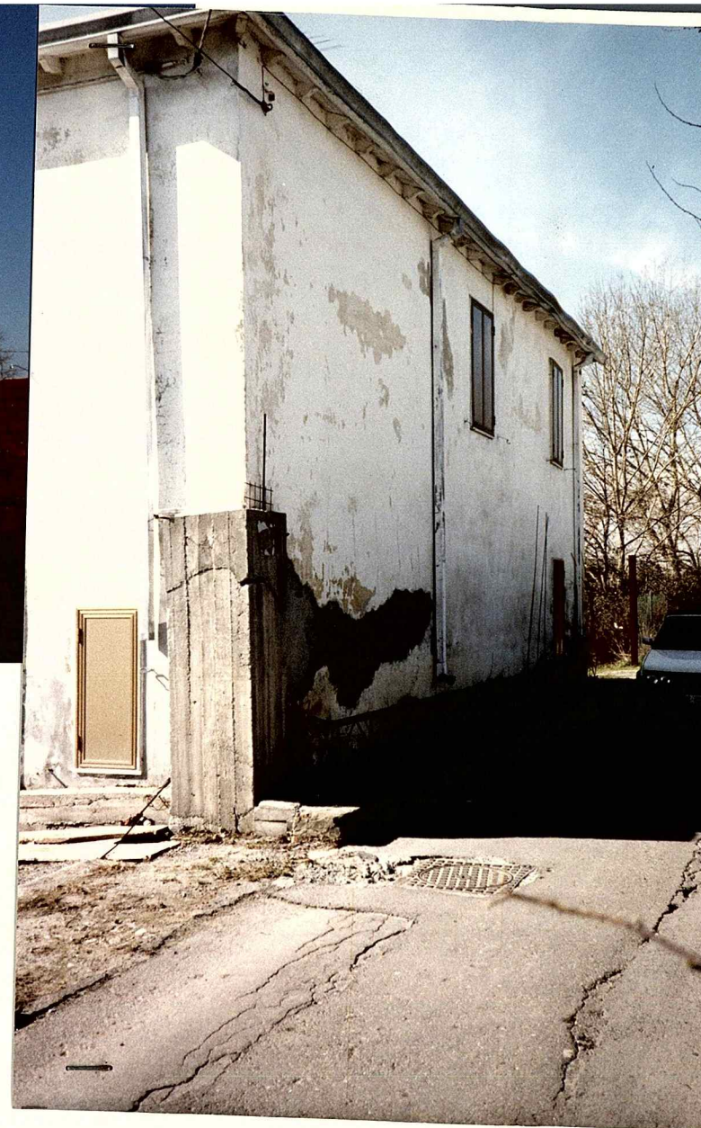
PROSPETTO LATO STRADA
