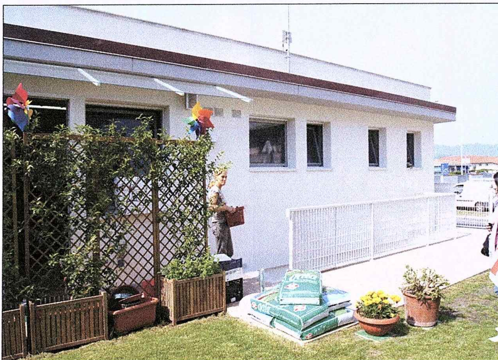
6) Foto retro fabbricato oggetto di intervento
