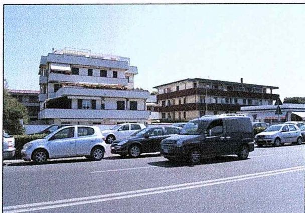
1) Foto fabbricati posti sul retro di quello oggetto di intervento
