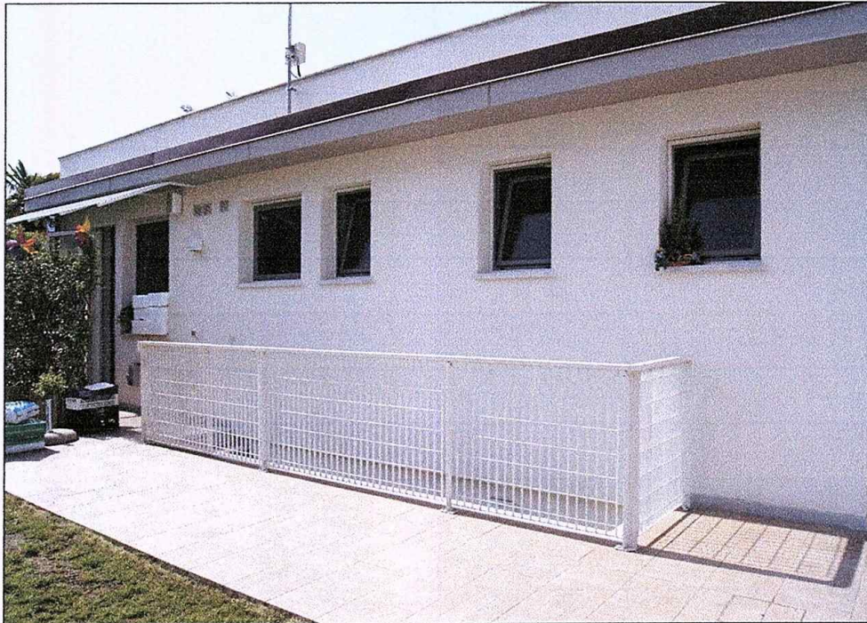
5) Foto retro fabbricato oggetto di intervento.
