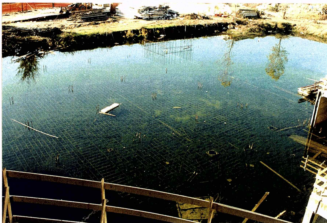
FOTO 6 : SCAVO ESISTENTE PER GARAGE
