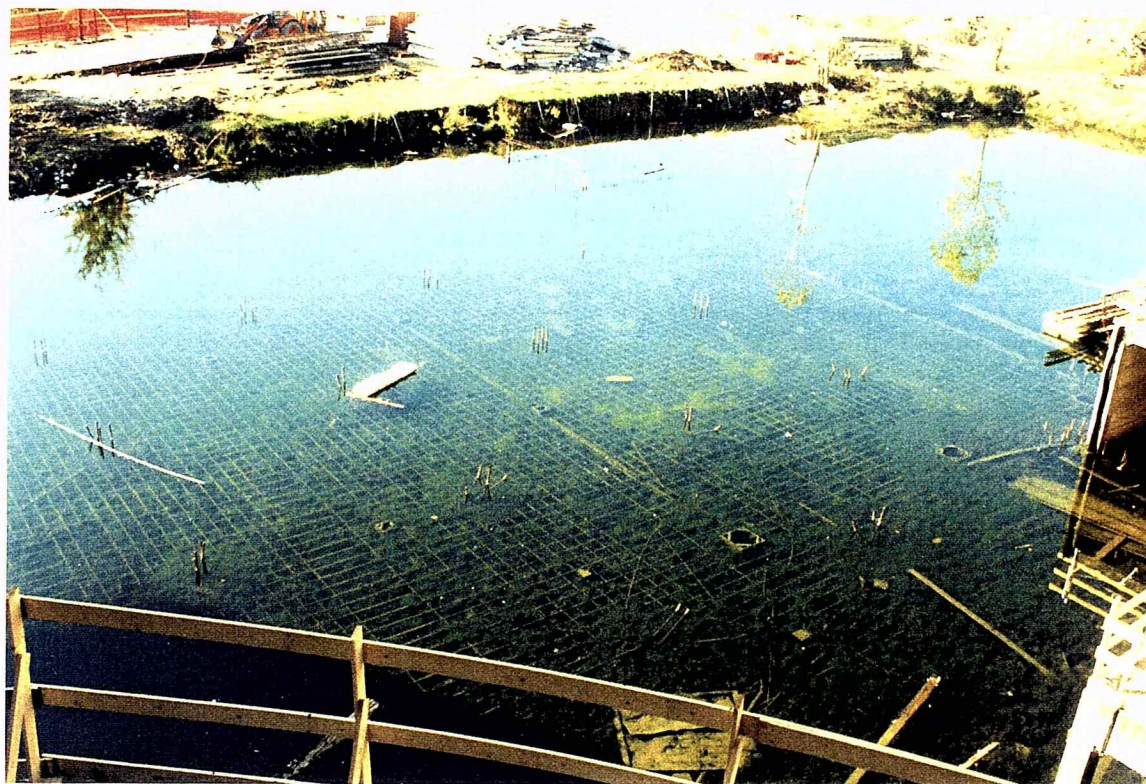
FOTO 6 : SCAVO ESISTENTE PER GARAGE
