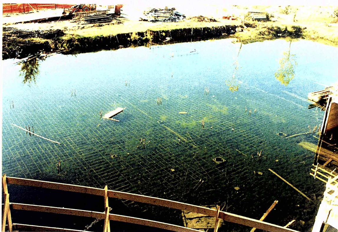
FOTO 6 : SCAVO ESISTENTE PER GARAGE
