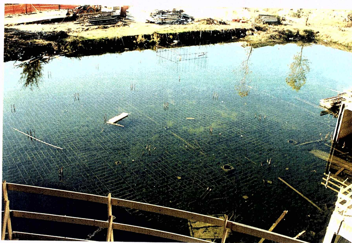
FOTO 6 : SCAVO ESISTENTE PER GARAGE
