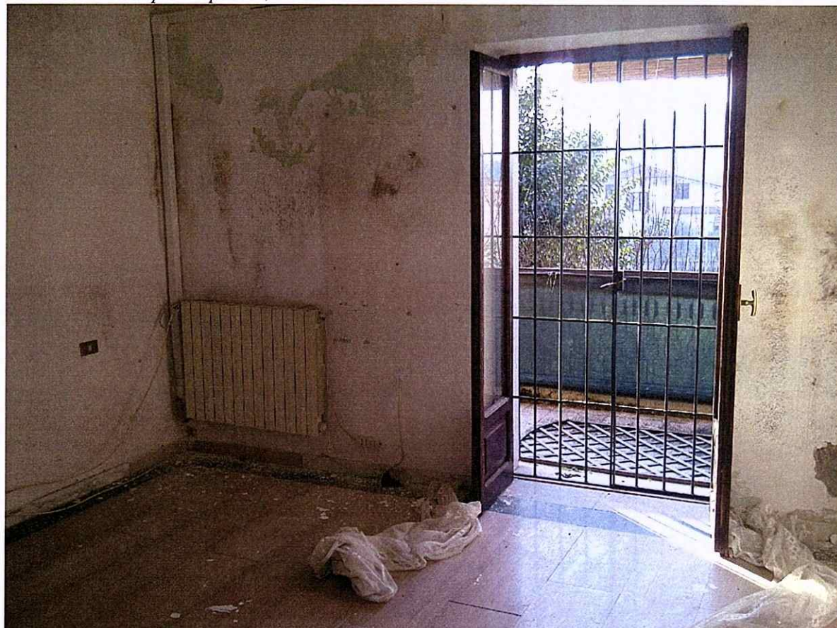
Foto 7 – Vano Al piano primo, lato Massa.
