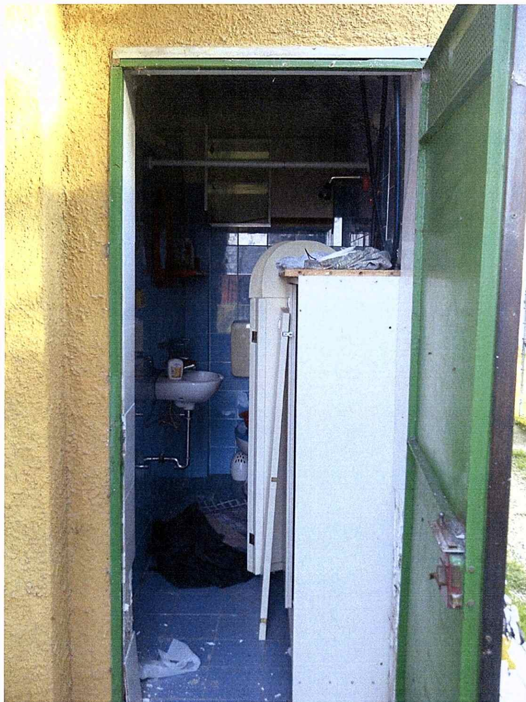
Foto 9 – Servizio igienico esistente al piano Trimo, lato Massa. Rifacimento rivestimenti e cambio sanitari. La porta esterna sarà veriate in finestra, realizzando un accesso allo stesso dall'interno, con il vano comunicante lato Carrara.
