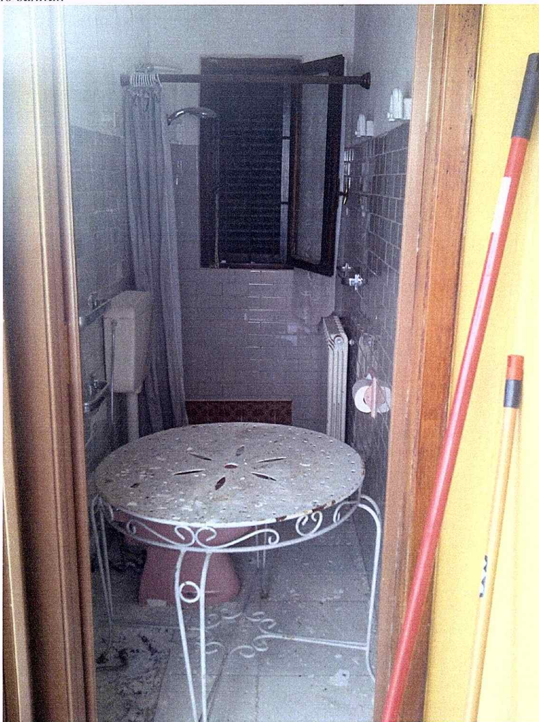
Foto 8 – Servizio igienico esistente al piano Primo, lato Massa. Rifacimento rivestimenti e cambio sanitari
