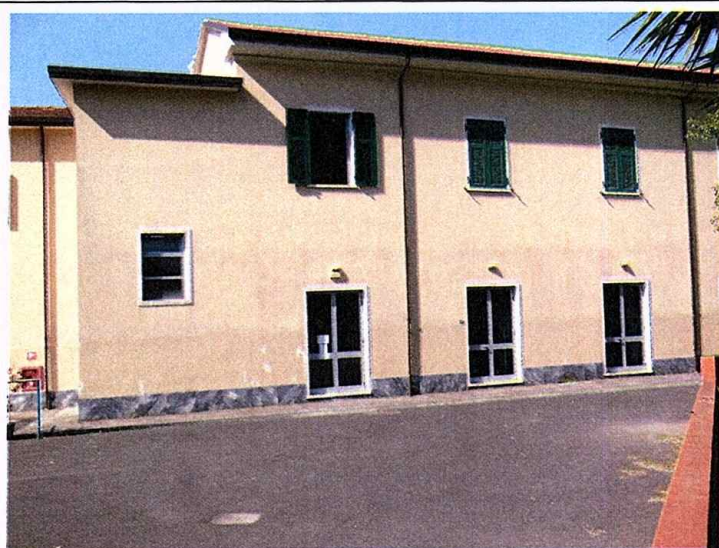
2 foto dal cortile zona aula multifunzione
