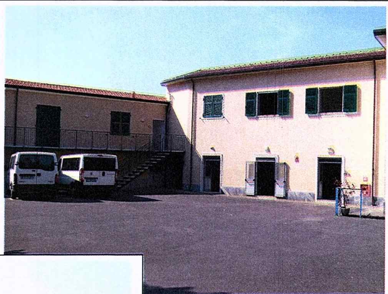
3 foto dal cortile zona mensa e parte oggetto di recente ristrutturazione con 4 alloggi
