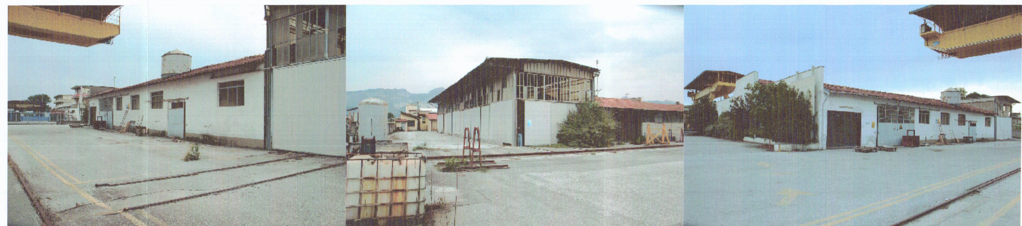
prospetto lato nord (foto n°1)
