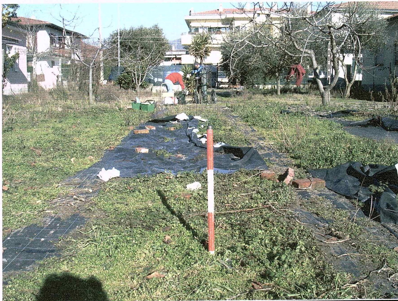
Foto 1. Visibile il sito edificabile e l'ubicazione delle prove penetrometriche
