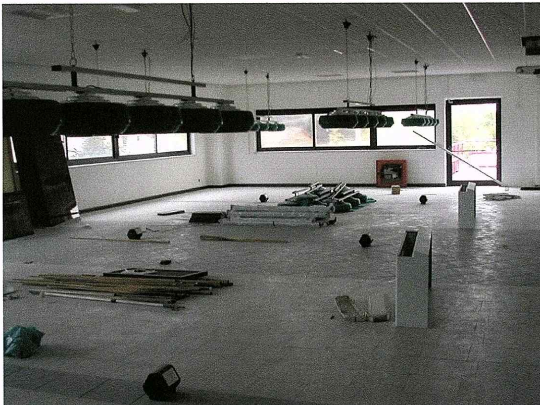
FOTO 1 – Sala biliardi con uscita di sicurezza verso la scala di emergenza
