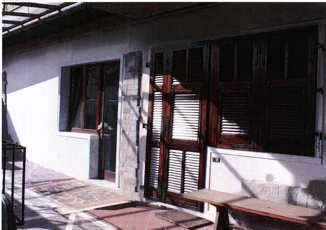
Foto2: Vista del lato Sud-Est del fabbricato, in particolare dei due ingressi del piano seminterrato.
