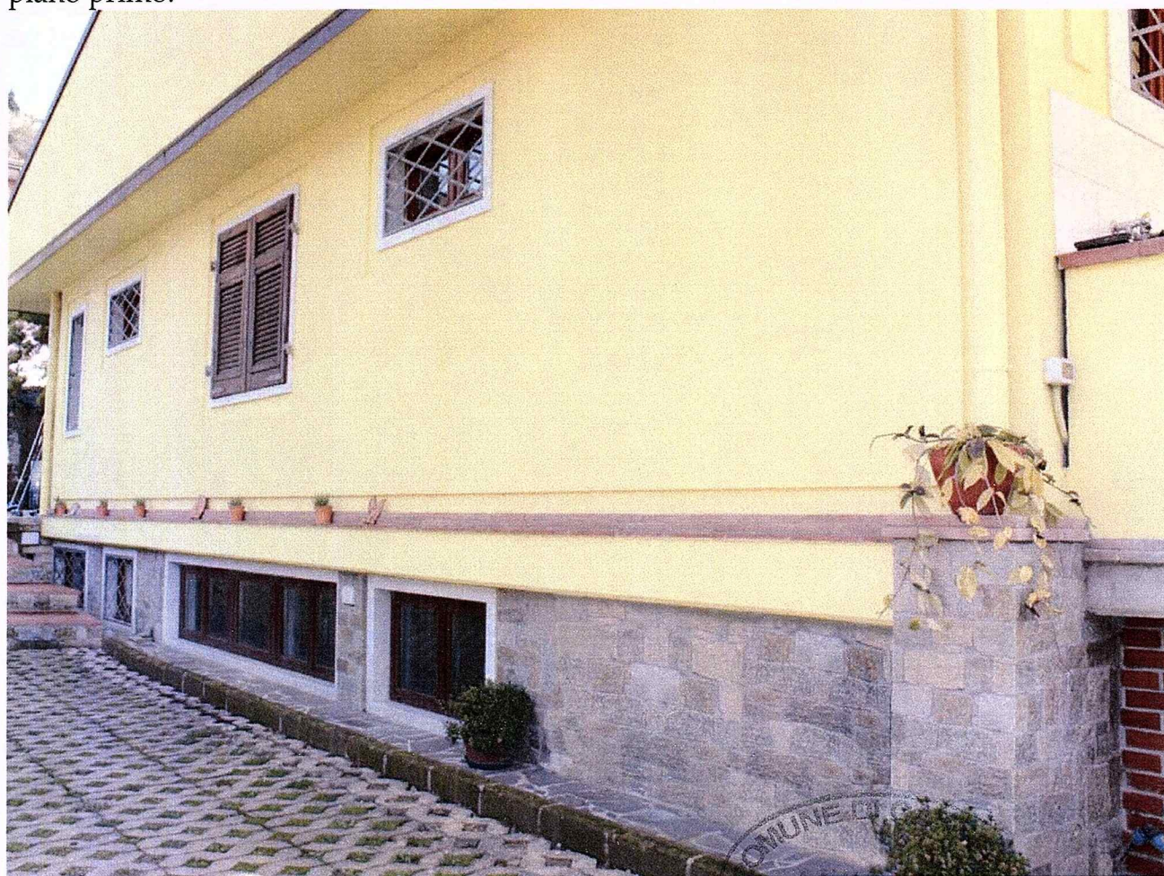
Foto1: vista del lato a Nord-Ovest del fabbricato, ove verrà realizzata la scala di accesso al piano primo.
