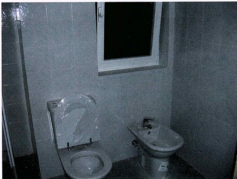
Foto 4- Locale bagno piano
