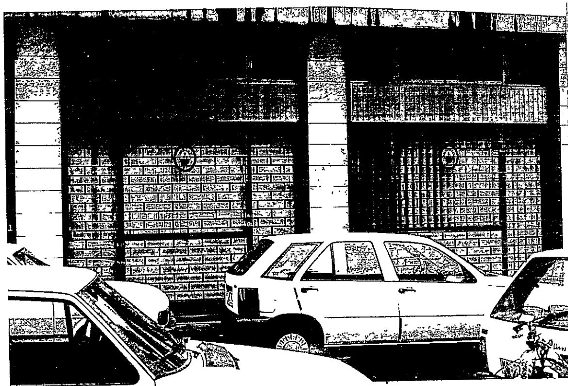
Infissi 10-11 stato attuale
