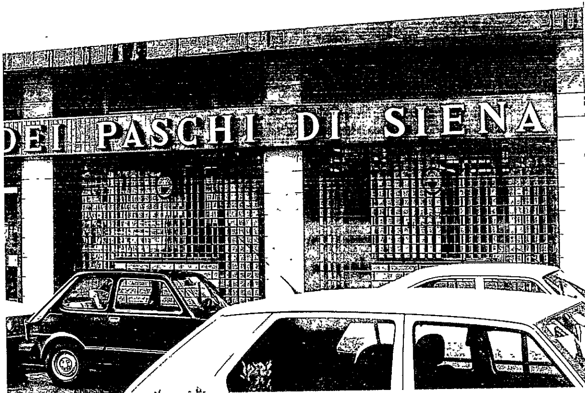
Infissi 8-9 stato attuale
