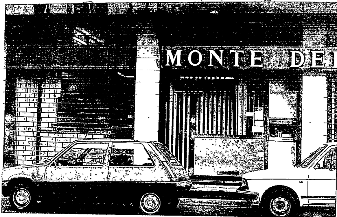
Infissi 2-3 stato attuale
