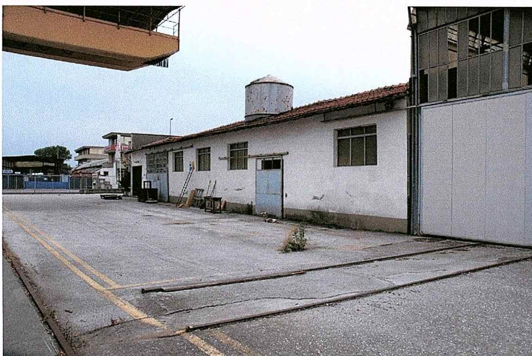
foto 8 prospetto lato Nord (volumi C", A)
