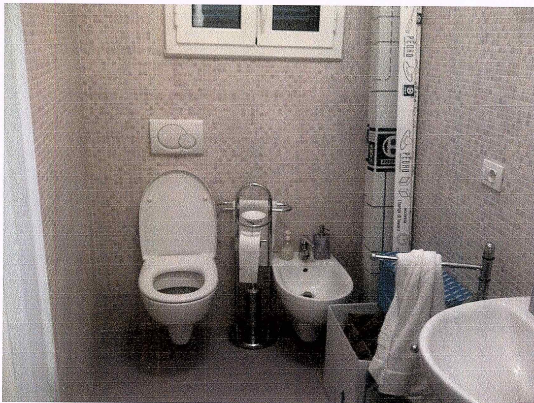
Foto n° 5 – Vista del servizio igienico
