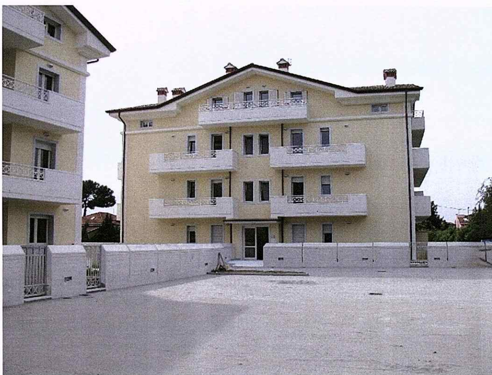
Fabbricato A foto 4
