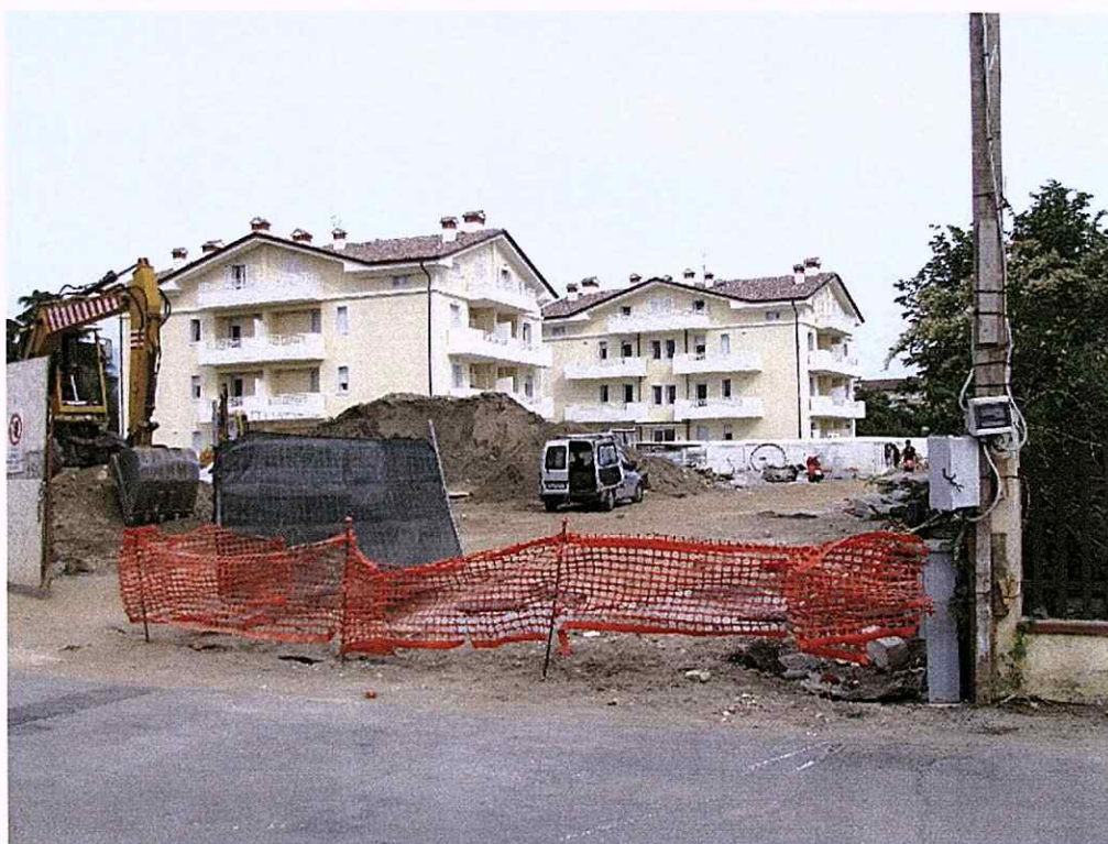
Fabbricato A foto 2
