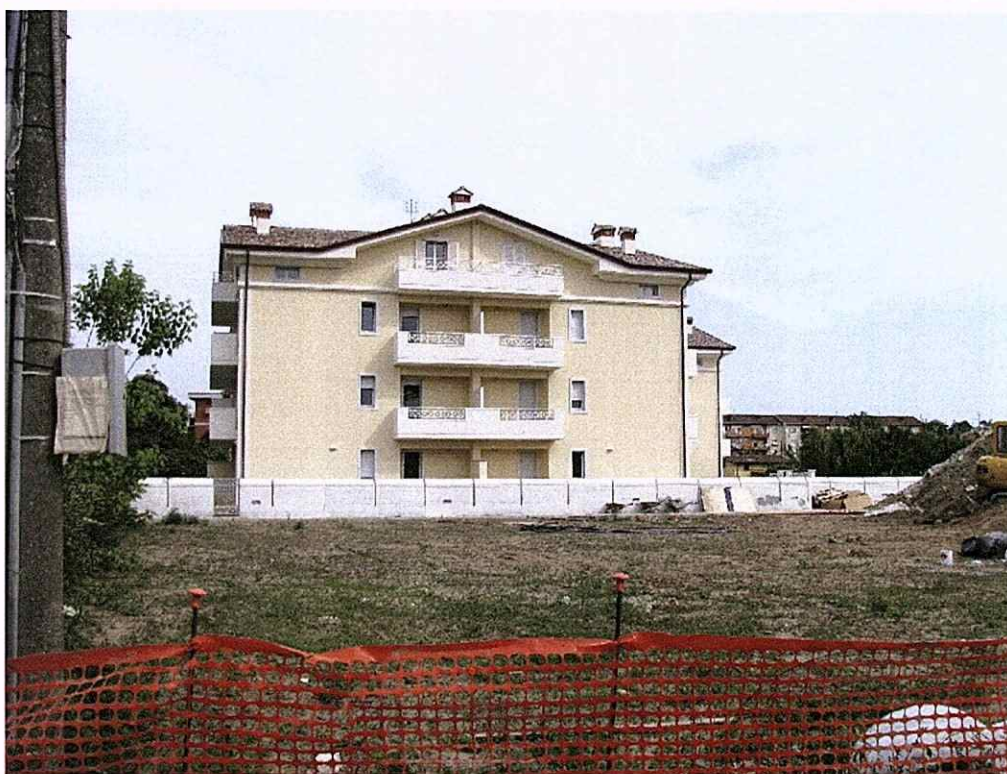
Fabbricato A foto 1
