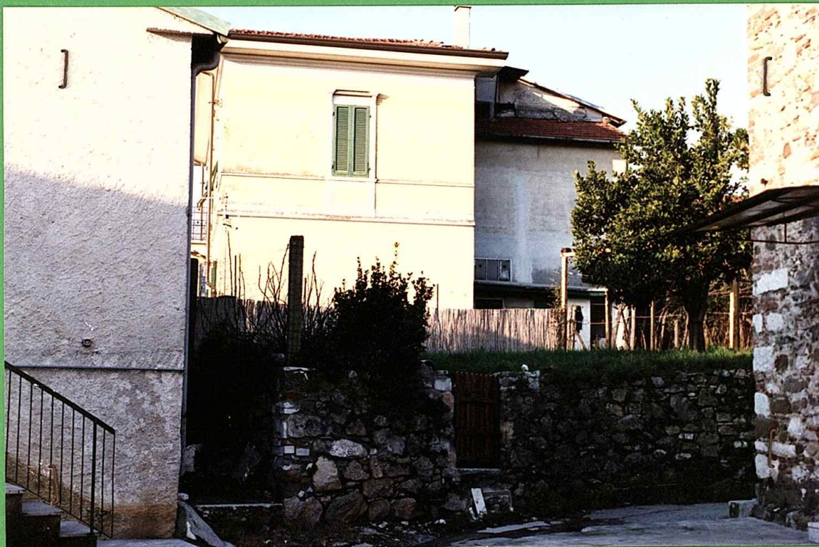
CARRARA LOC. S. LUCA. VIA PROVINCIALE N° 64 LATO RAMPA DI ACCESSO DA REALIZZARSI
