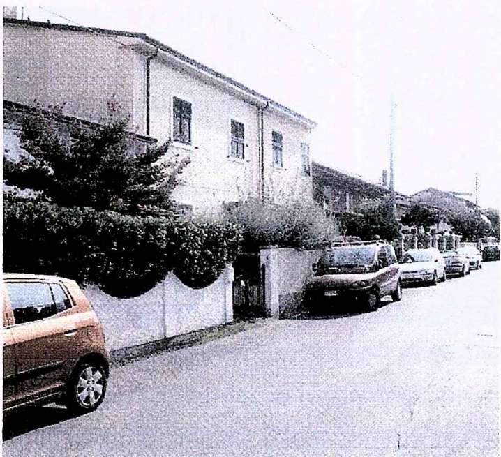
Fronte Sud: via Cairoli
