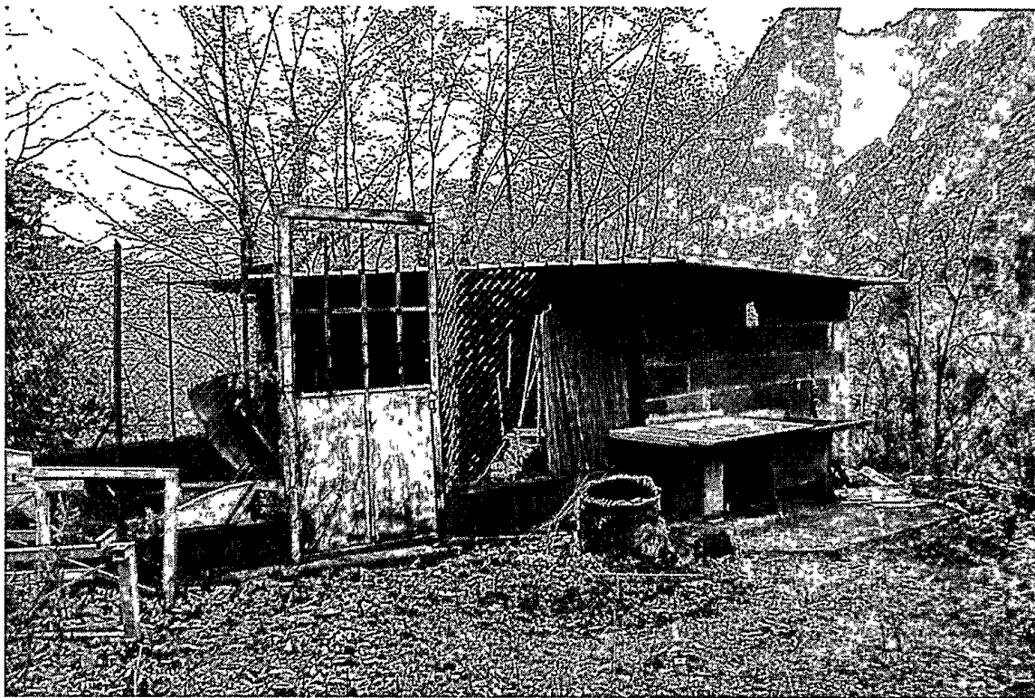
FOTO 5 – Fabbricato in demolizione
