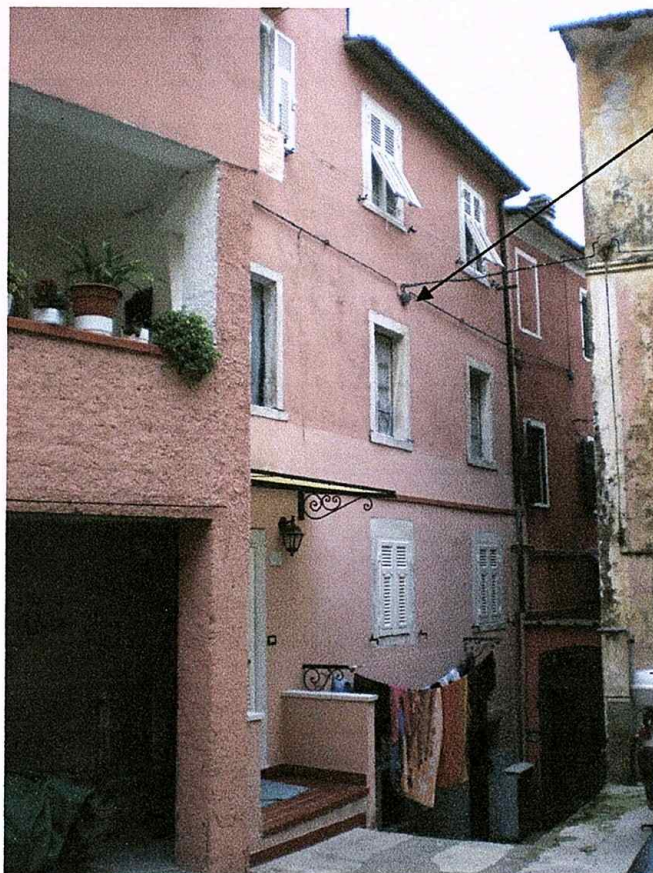
foto 1 – immobile oggetto d'intervento – vista fronte strada
