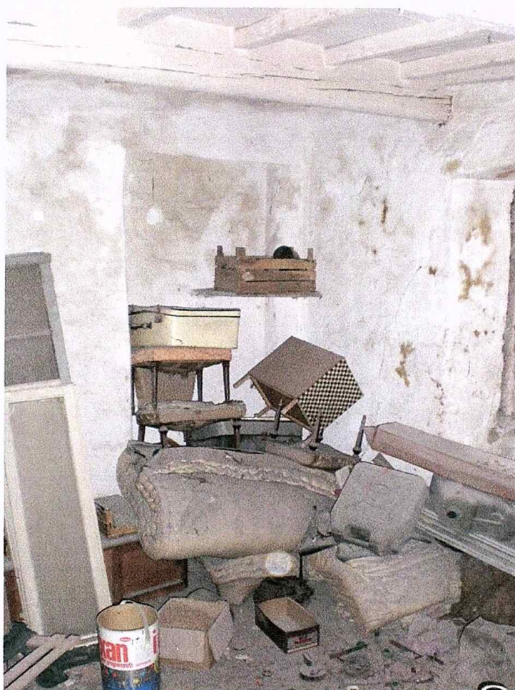
foto 4 – Immobile oggetto d'intervento. Vista interna
