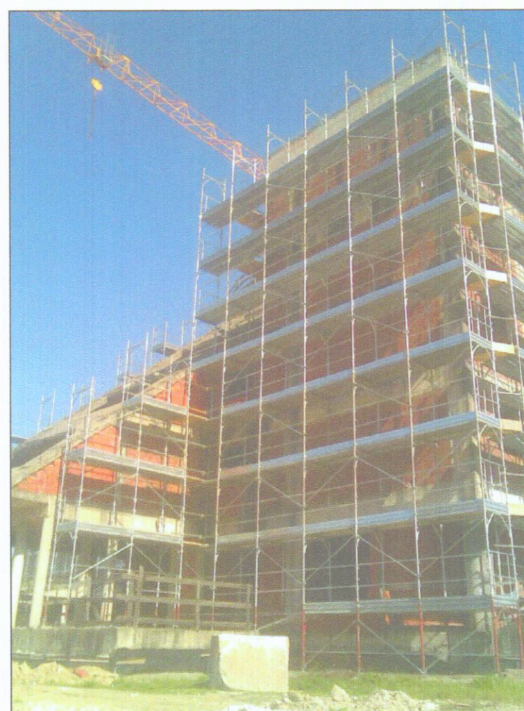
4 Vista lato sud
