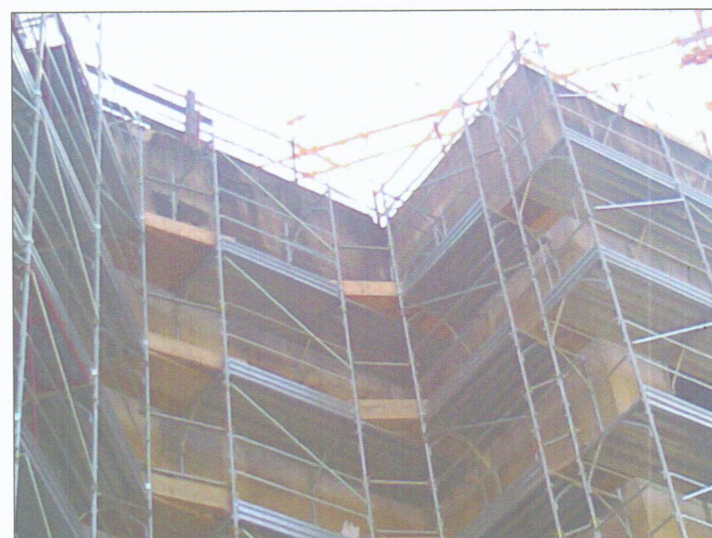
7 Vista lato est
