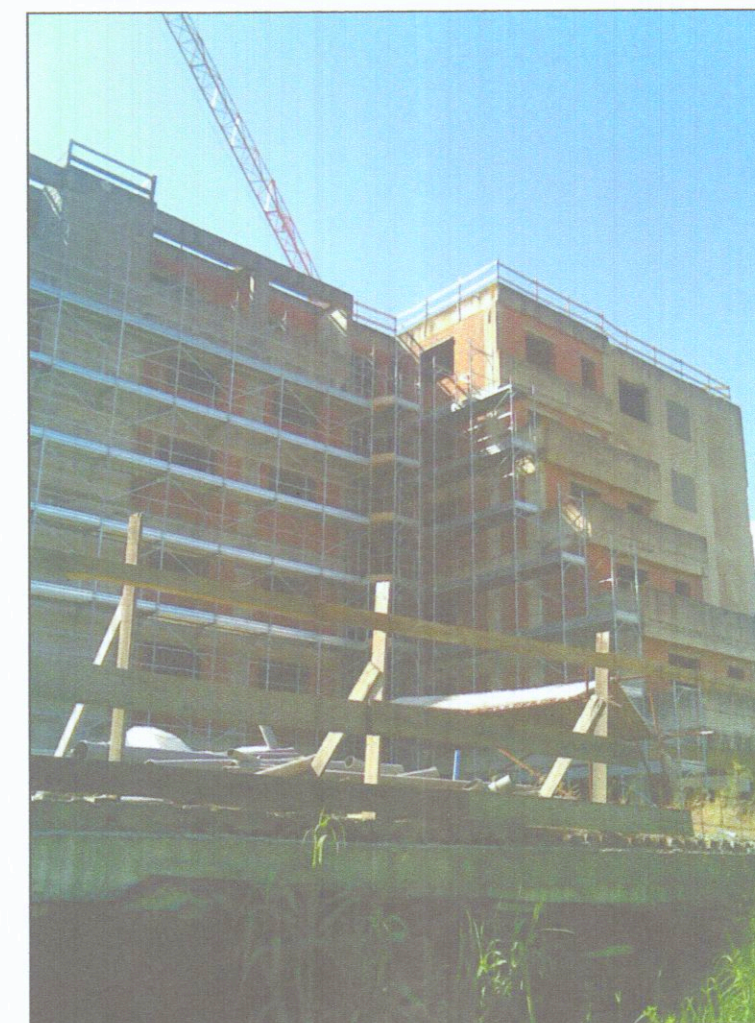
5 Vista lato sud
