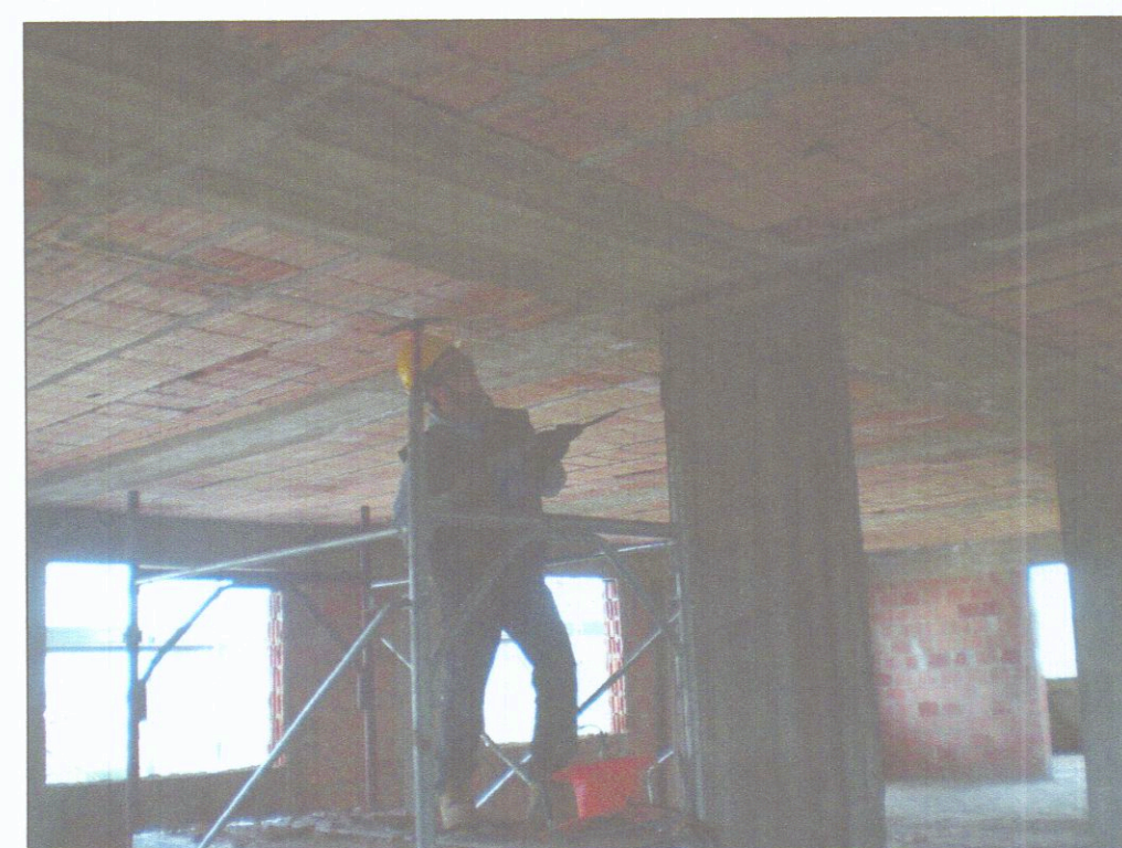
10* Trattamento ferri, piano terzo
