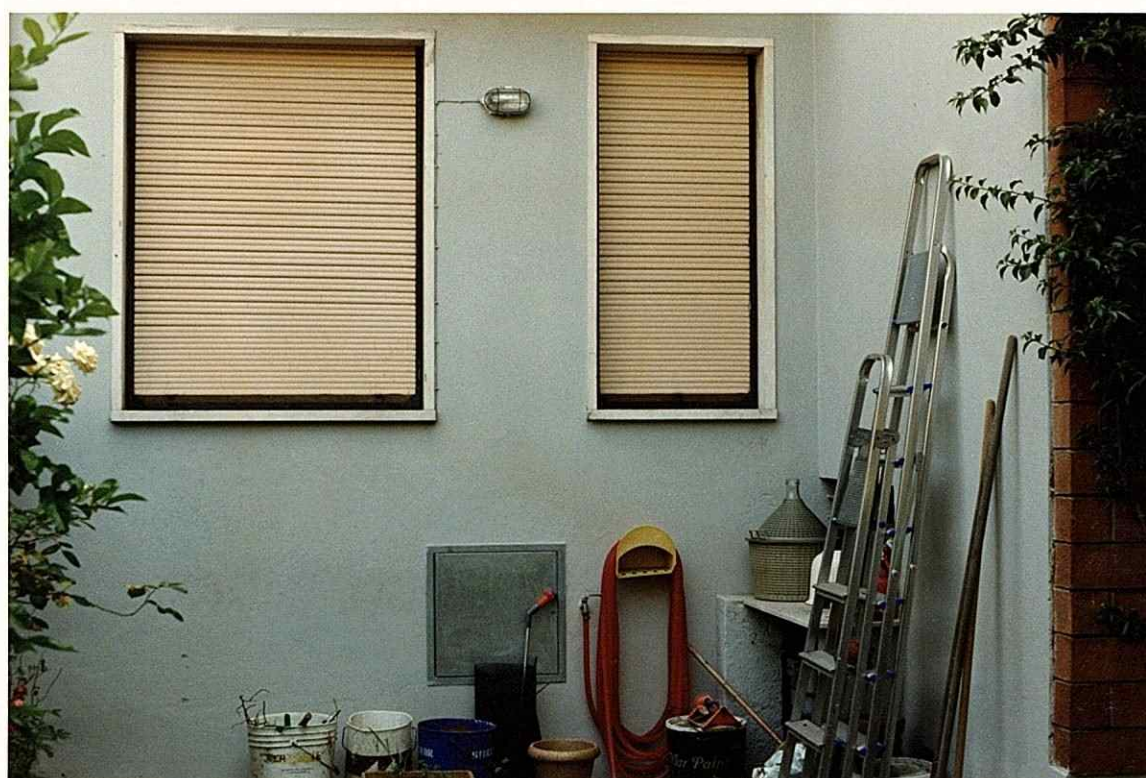
FINESTRA PIANO TERRA
