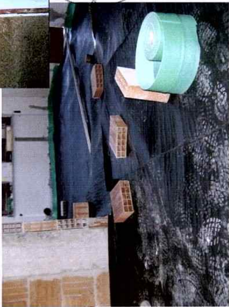
Foto in corso d'opera - posa di tappeto fonoassorbente
