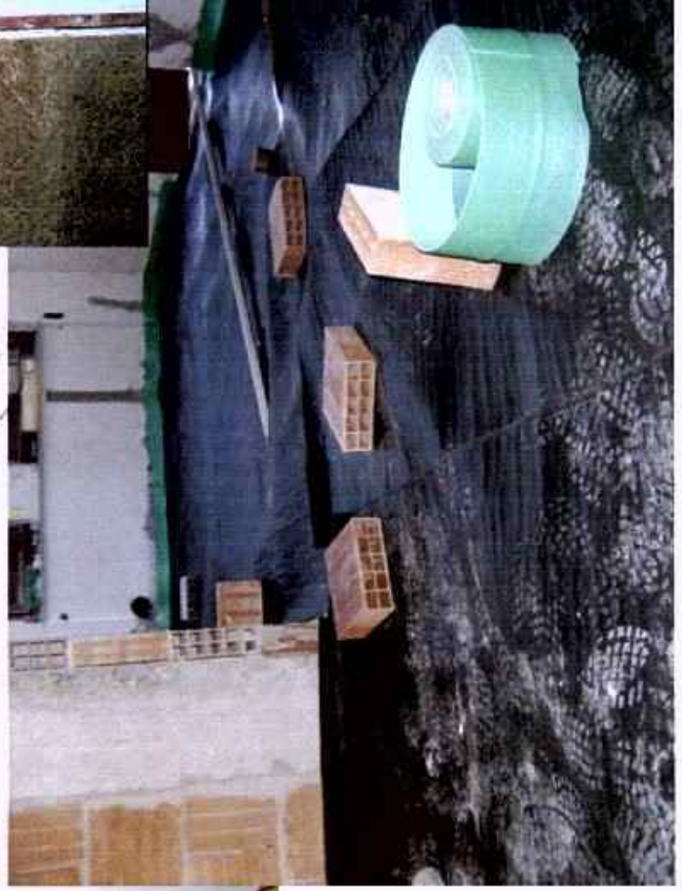
Foto in corso d'opera - posa di tappeto fonoassorbente
