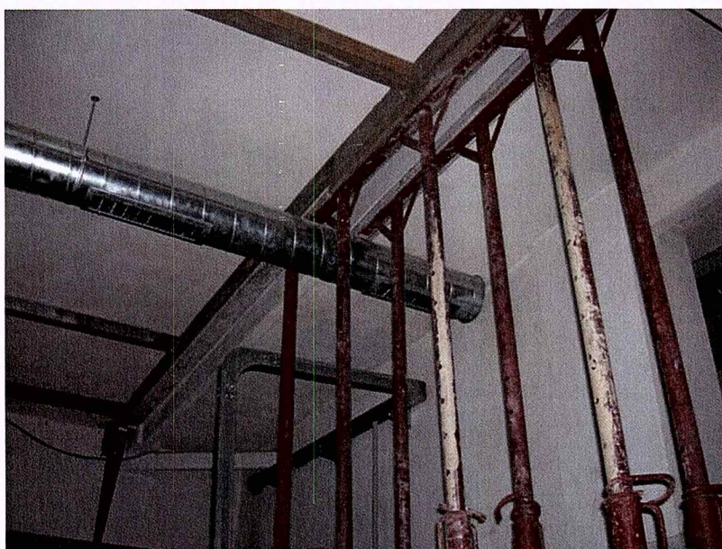
Figura 2 PUNTELLATURA SOLAIO LATO MASSA SOTTOMURO
