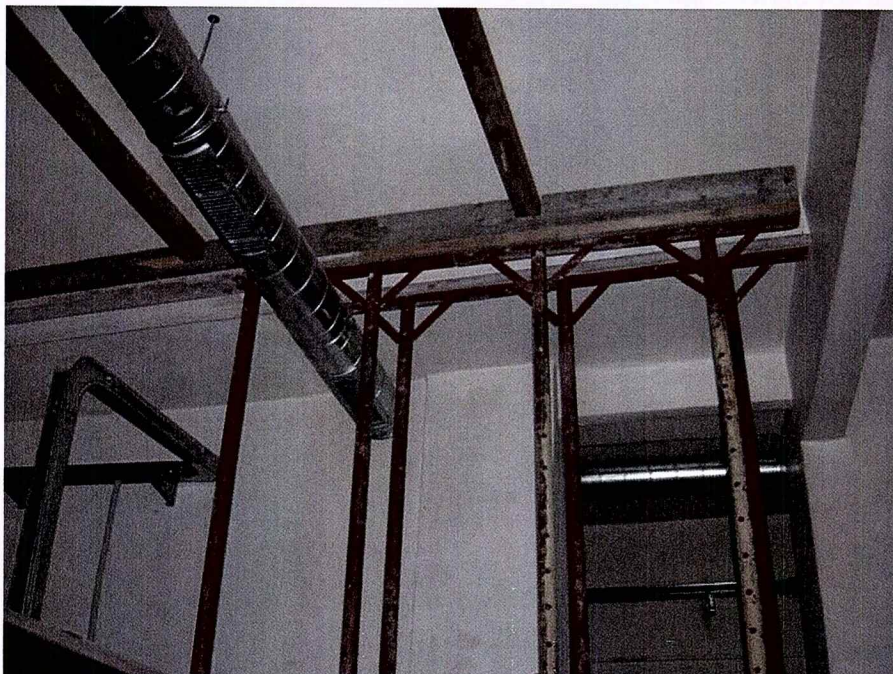
Figura 3 PUNTELLATURA SOLAIO LATO MASSA SOTTOMURO TESTATA
