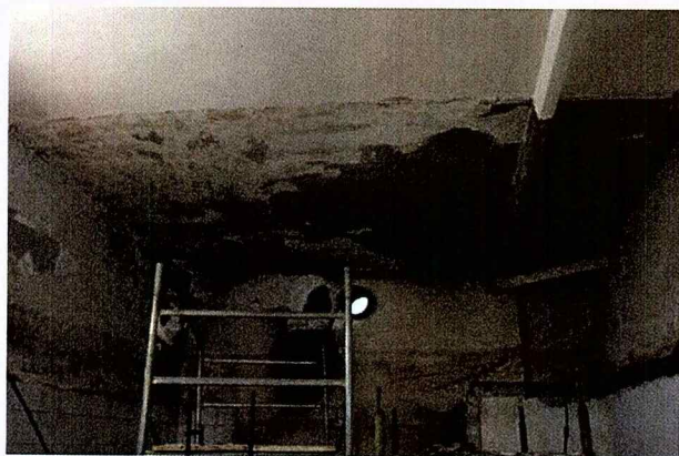
Area forno dopo asportazione vecchio forno
