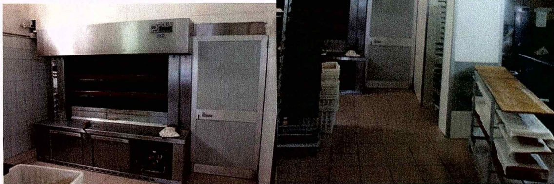
Vecchio forno prima della demolizione
