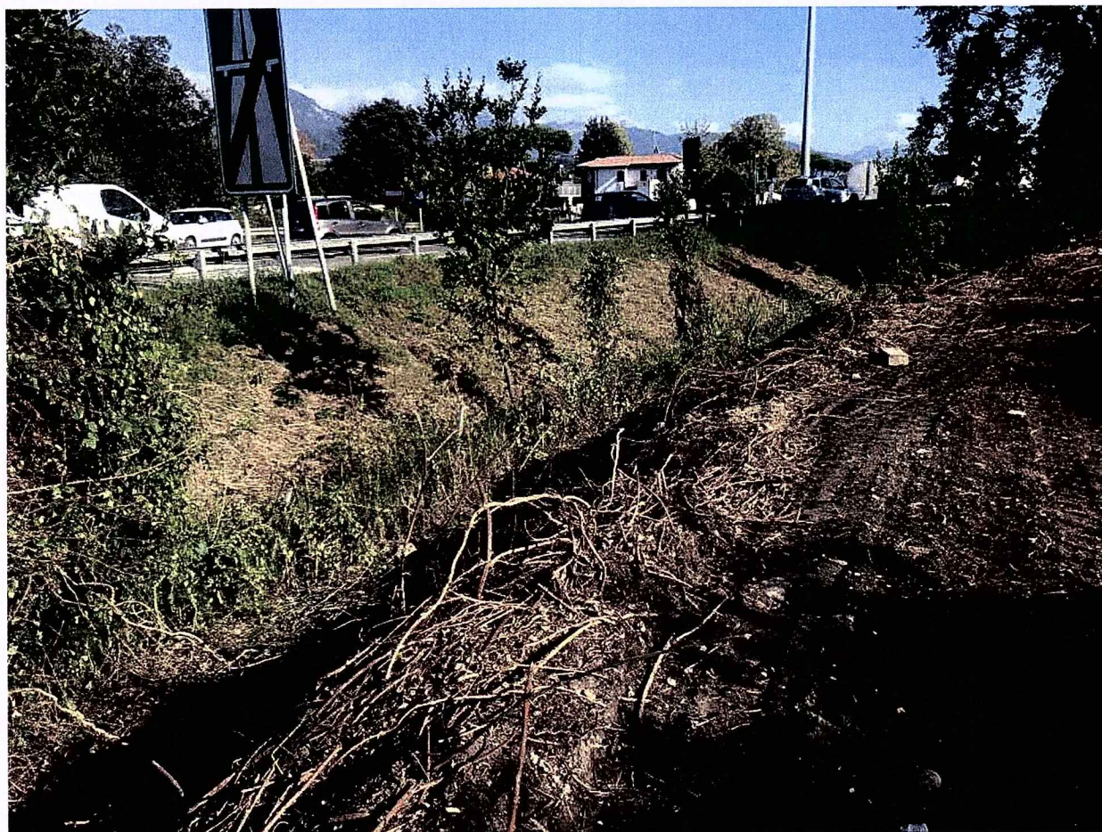
Fig.2: Foto del confine nord-est del lotto con la presenza della fossa di raccolta acque
