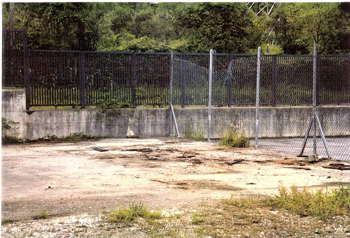
AREA ALLOGGIO SHELTER - RECINZIONE INTERNA
