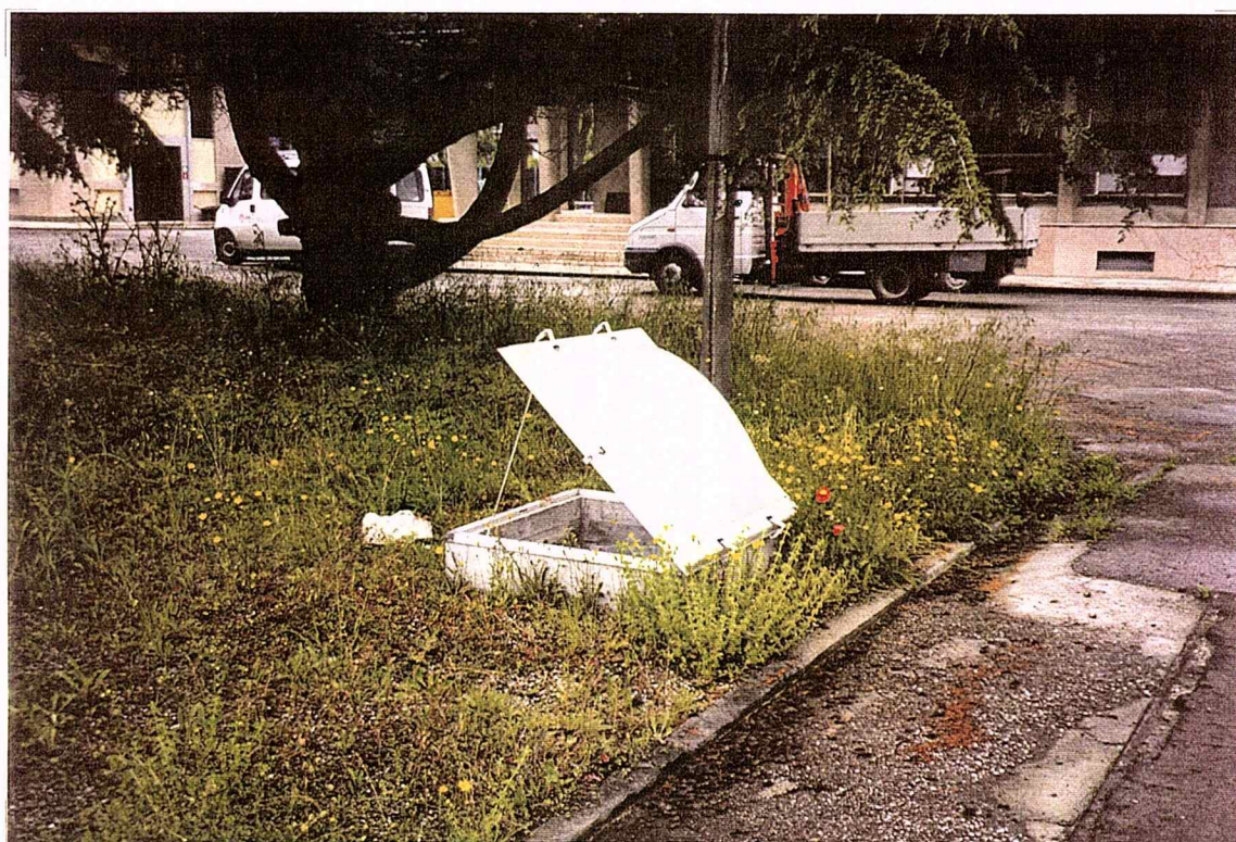
PASSO D'UOMO TIPO - Dimensioni 1,10 x 1,10 x 0,25 h.
