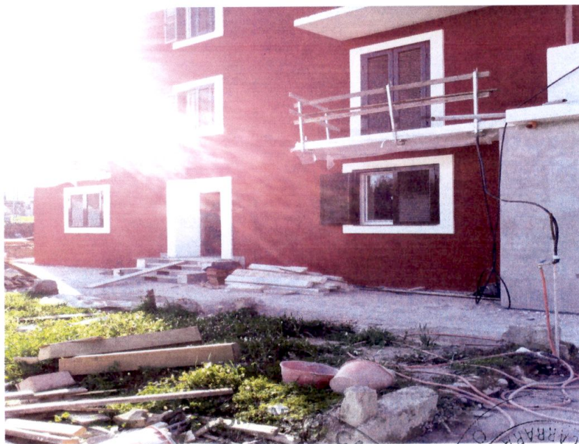
fotografia dello stato della facciata interna.
