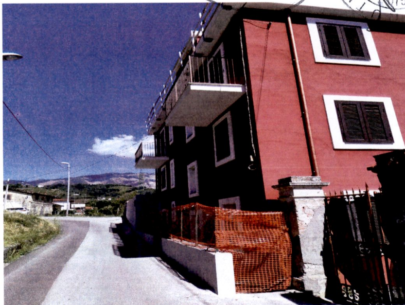
La fotografia sopra allegata rappresenta lo stato della facciata sul lato via Agricola e l'accesso e la recinzione originale in corso di ristrutturazione.
