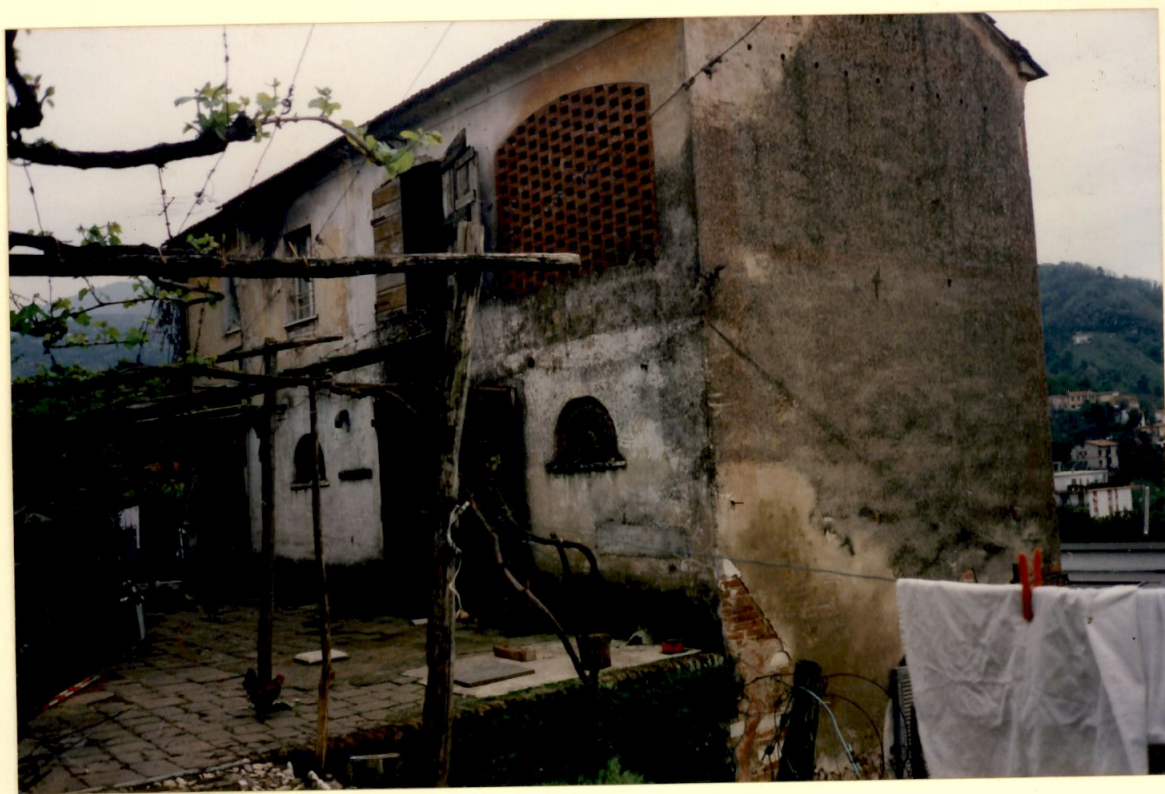
PROSPETTO NORD E FIANCO SUD-OVEST
