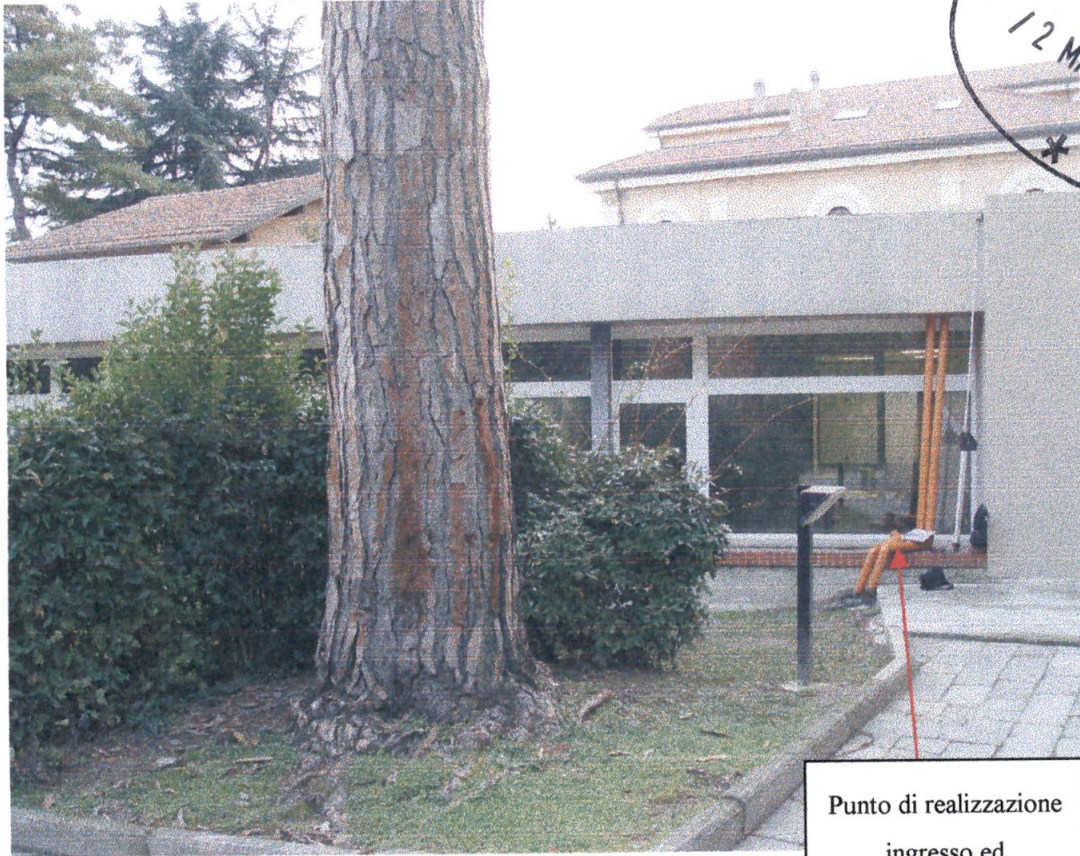
Foto 6 – Vista prospetto principale
