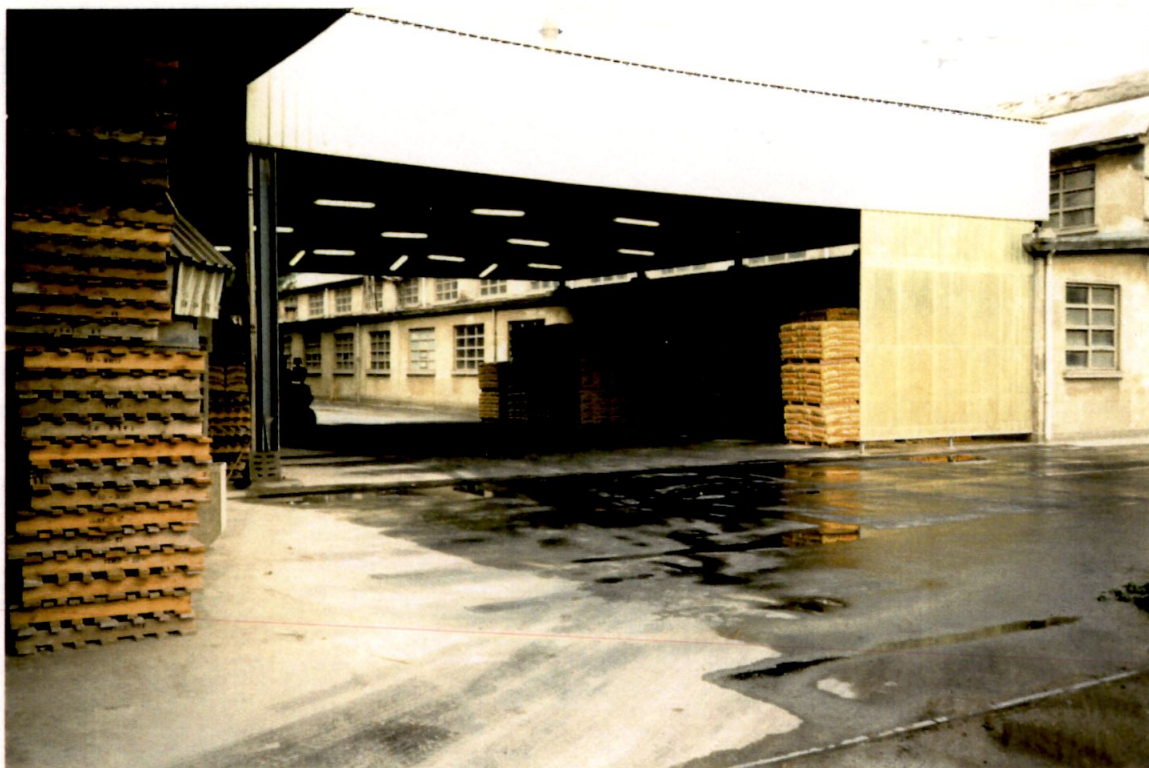
VISTA DA NORD
